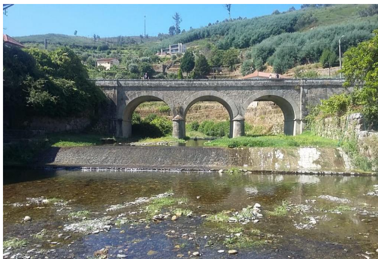
Figura 20: Ponte sobre a Ribeira de Pomares
