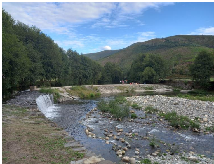
Figura 14: Açude da Moenda
