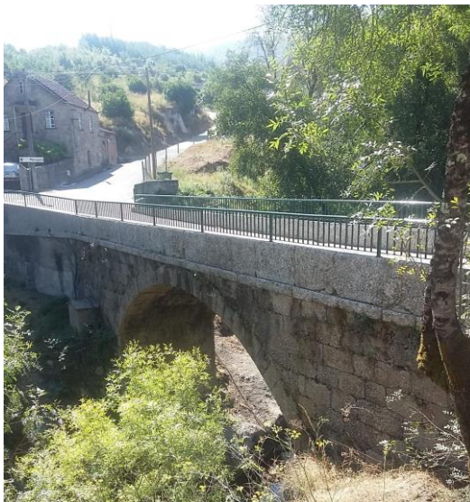
Figura 24: Ponte de Santo António do Alva Fonte: Elaboração Própria
