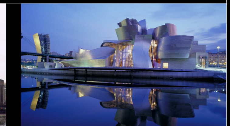
Museu Guggenheim de Bilbao, Frank Gehry
