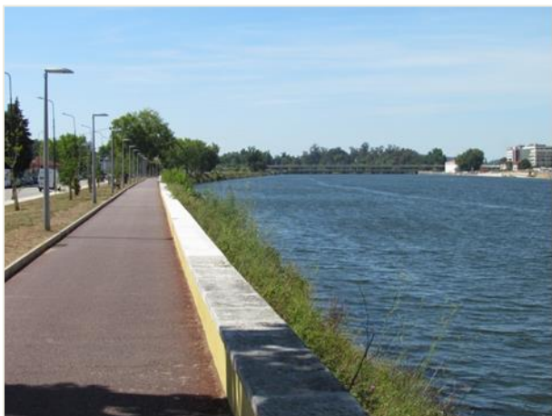
Figura 120 - Passeio pedonal na margem esquerda do rio a montante do Açude - ponte
