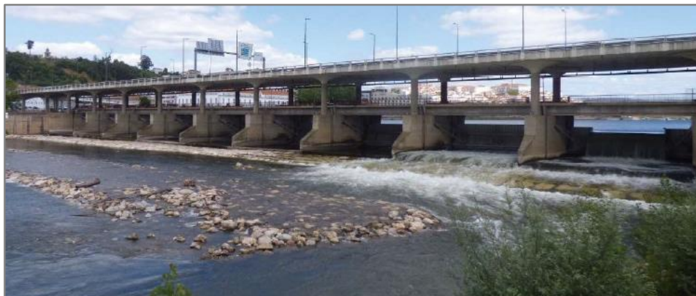
Figura 76 – Açude-ponte de Coimbra
