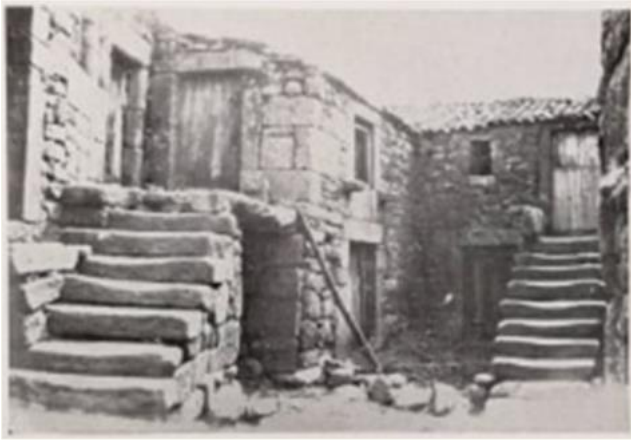
Figura 98 - Um recanto de Vila - Cova - de - Tavares. Casas de loja e sobrado. As ombreiras e vêrgas das portas e janelas de cantaria; o resto da pedra é grosseiramente aparelhado
