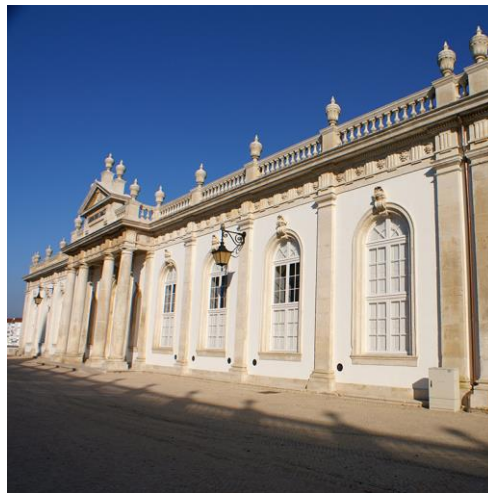
Imagem 4 – Fachada Frontal do Laboratório Chímico
