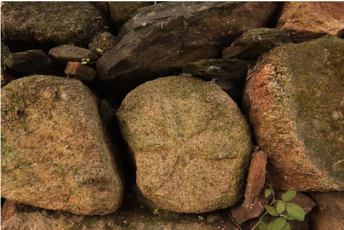
b) PL.42. Muro na rua Espírito Santo, no alinhamento da passagem da ponte.
