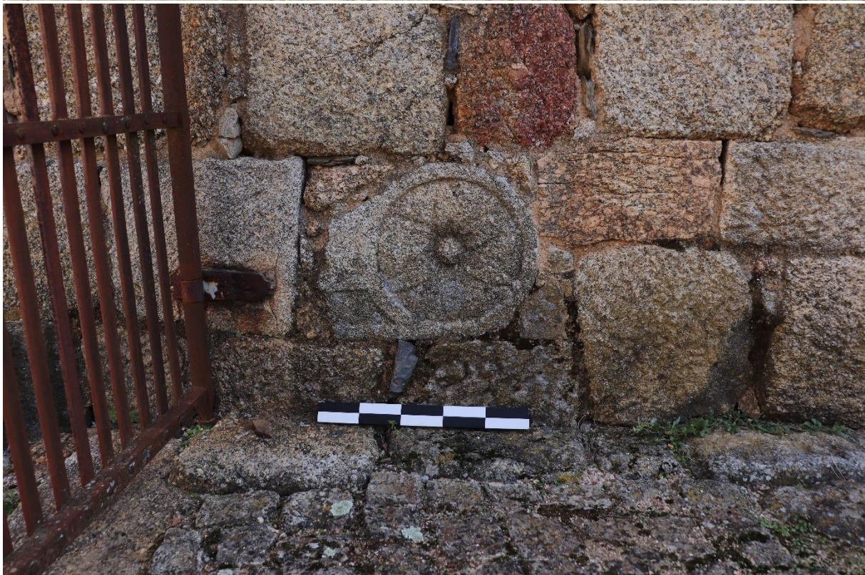
a) PL.31. Parede oeste do Lagar das Varas.
