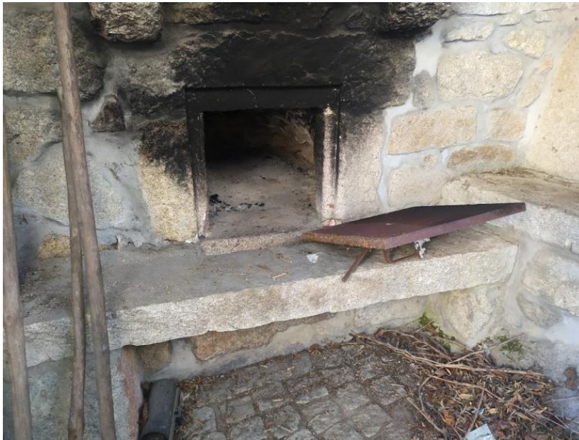
Forno: Nelas (Construção em pedra e tijolo) Fonte: o autor
