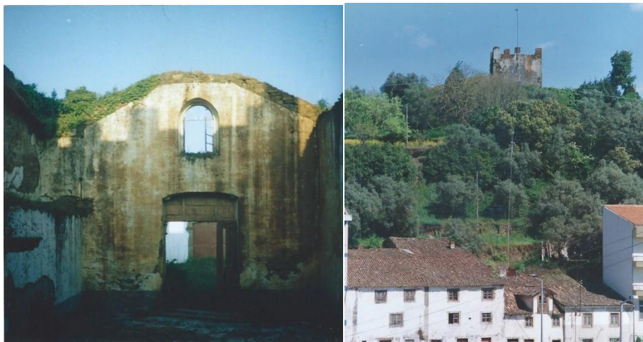
Interior da capela S. João Batista (1999) Vista da Torre de Menagem (1999)
