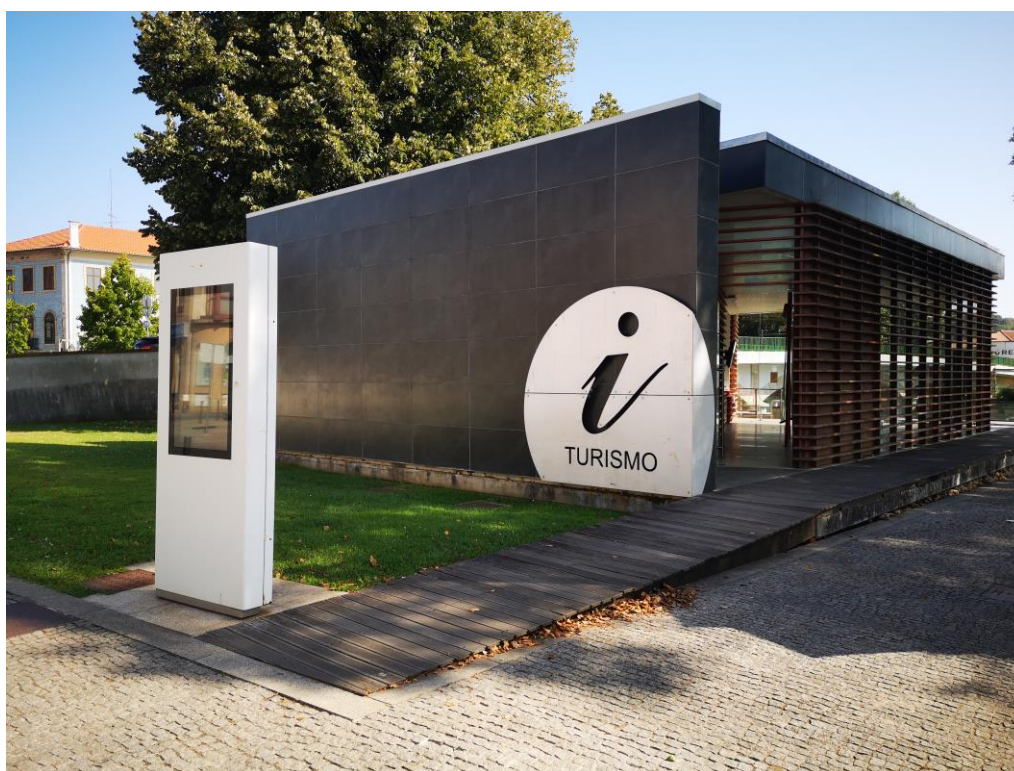
Figura 24 Sinalética e Rampa de acesso ao Posto de Turismo de Águeda
