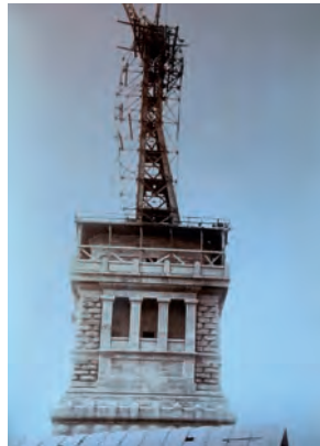
4. Autor desconhecido, A Estátua da Liberdade em Nova Iorque: montagem da estrutura metálica no pedestal, 1886.
