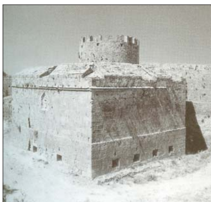
Em cima, desenho e foto do proto-baluarte do Posto de Espanha, com casamatas abobadadas e canhoneiras rasantes ao terreno e plataforma com posições para artilharia no terraço, mantendo completa separação do interior da fortificação, mas permitindo o circuito da falsabraca. Ao lado, desenho com a demonstração perspectivada do bastião quadrangular de d'Aubusson, agregado à cortina do "Posto da Provença" (in Stephen C. Spiteri, Fortresses of the Knights - 2001, Book Distributors Limited, Malta, pp. 114 e 117).
