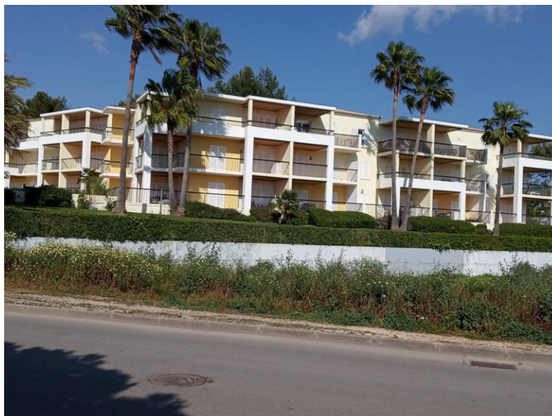
Figura 3. Prédios Habitacionais de segunda habitação de população estrangeira – Montes de Alvor
