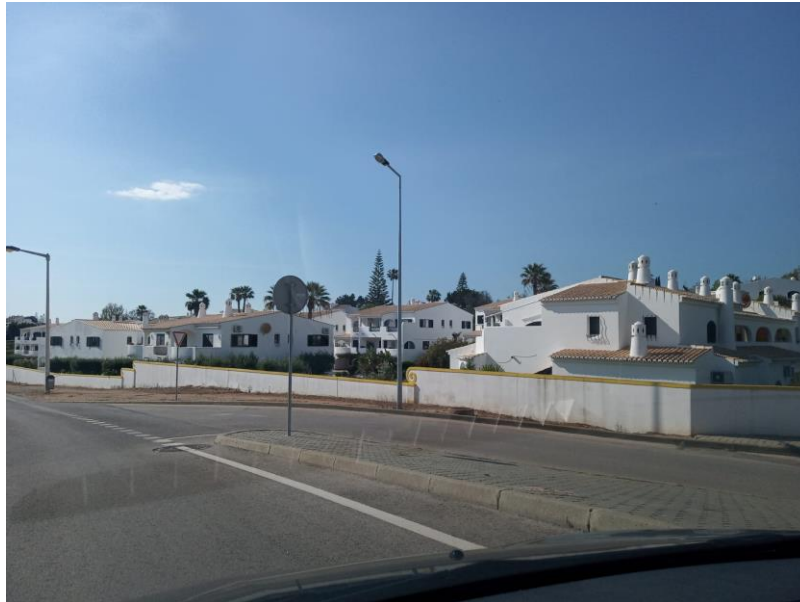
Figura 2. Zona residencial em Alvor, composta maioritariamente por segundas habitações
