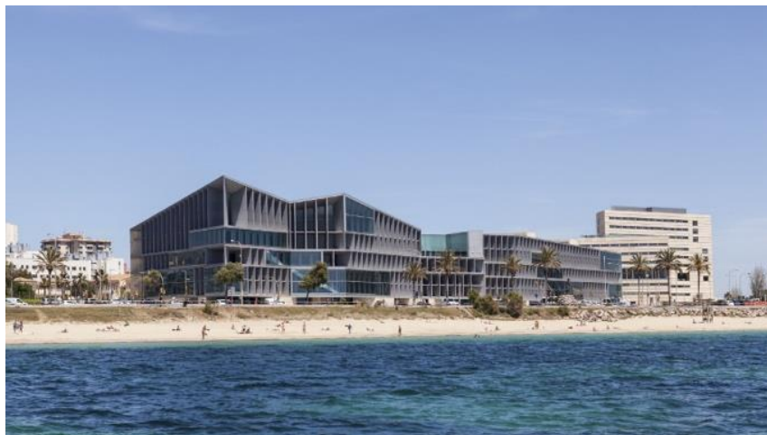
Figura 109 - Palácio de Congressos e Hotel de Palma, de Francisco Mangado & associados, “Prémio de Arquitetura Espanhola pelo CSCAE em 2017
