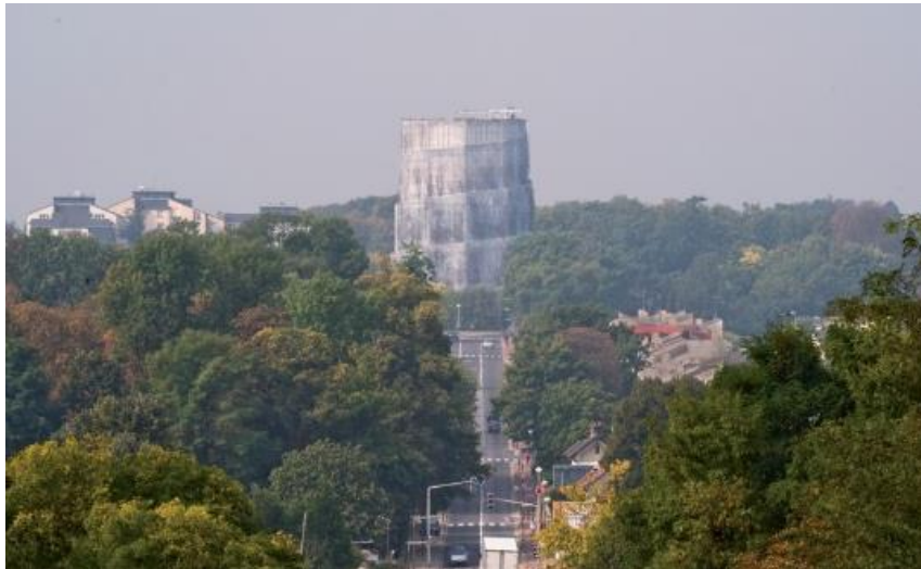
Figura 10 - Depósito de água, « Château d'eau », Christian Portzamparc, 1974, Paris (Seine et Marne)
