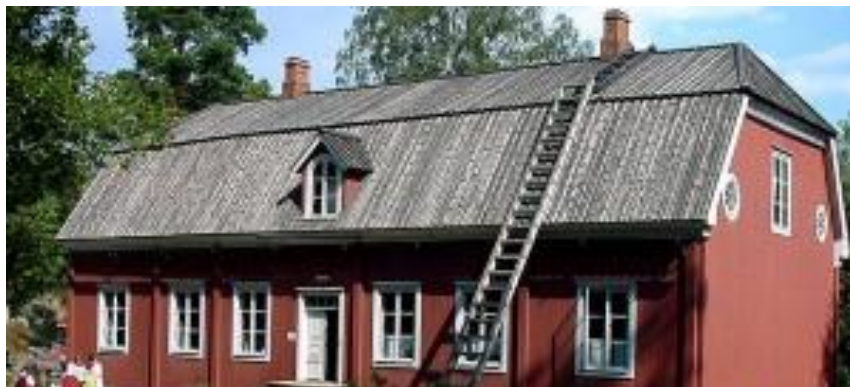
Figura 58 - Presbitério do séc. XVIII, construção em madeira (pintada)
