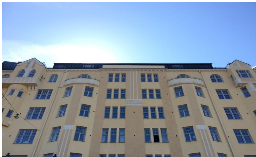
Figura 70 - Vista de fachada de edifício Arte Nova, Helsínquia
