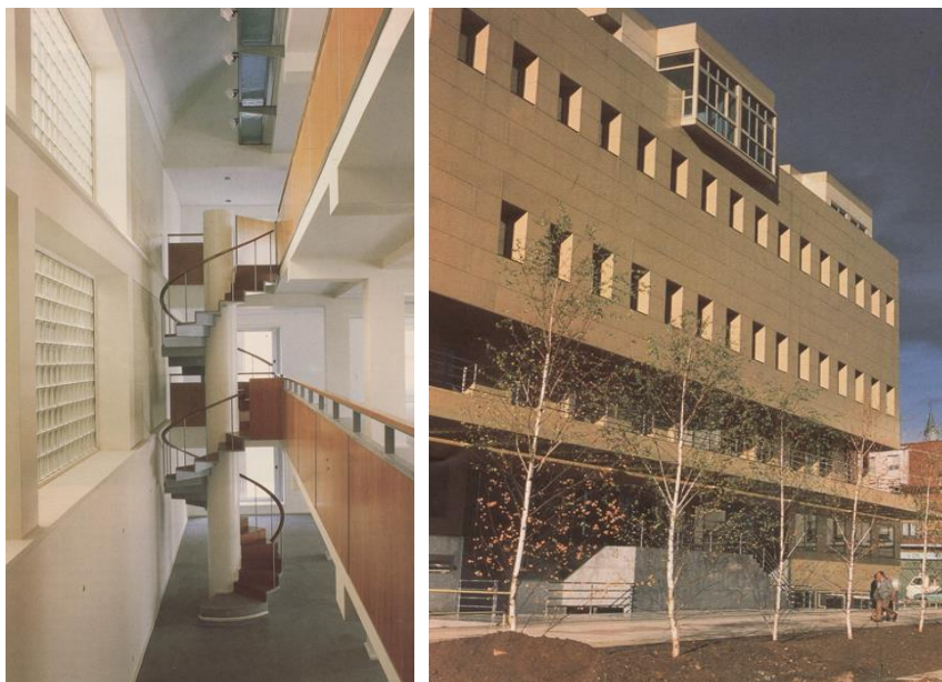
Figura 112 - Imagem do Edifício dos Serviços Sociais Porta de Toledo, Madrid, da autoria de Navarro Baldeweg, premiado na “I Bienal de Arquitectura espanhola”, 1990
