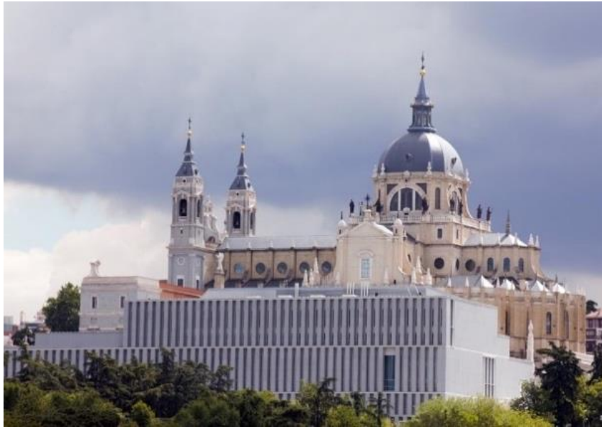
Figura 108 - Museu das Coleções Reais, Madrid, de Mansila e Tuñon, “Prémio de Arquitetura Espanhola pelo CSCAE em 2017
