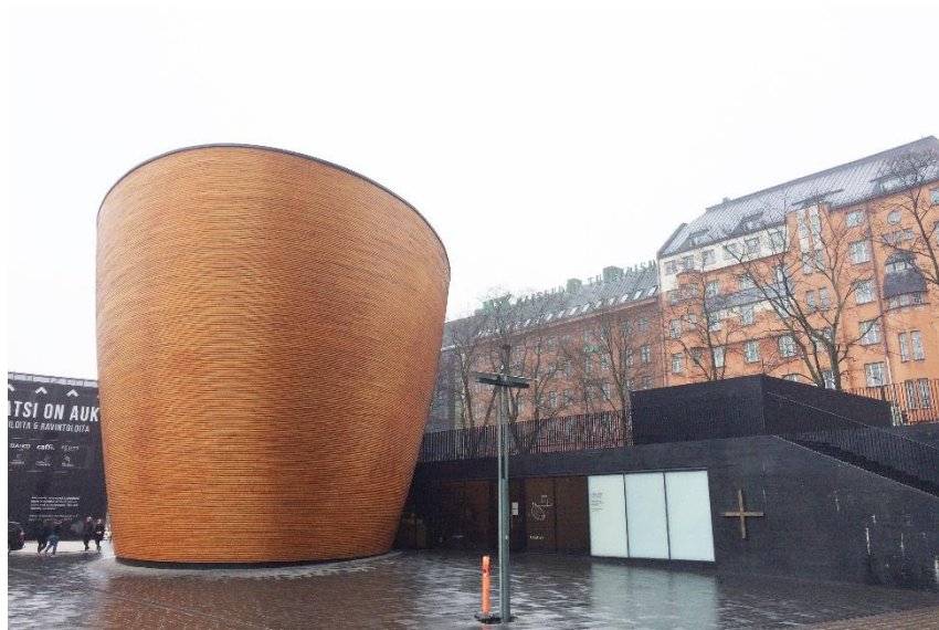
Figura 64 - Capela do Silêncio, em Helsínquia, projeto de K2S Architects
