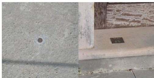
Marcas de nivelamento cravadas no solo. (Foto da DGT)
