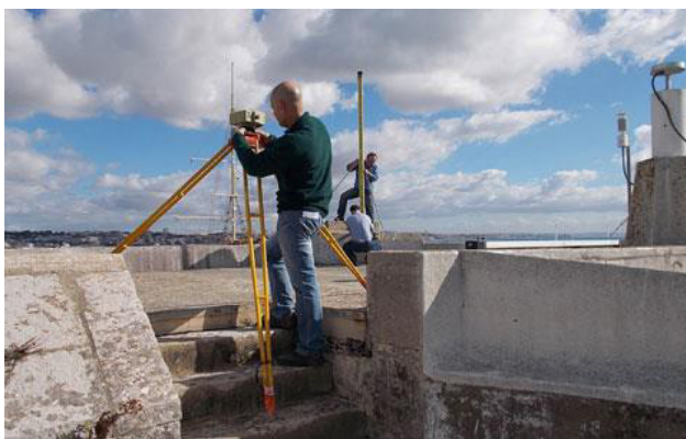
Trabalhos de nivelamento geométrico. (Foto da DGT)
