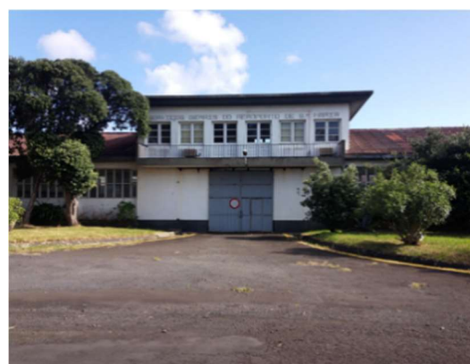
Figura 4.81 – Edifício da SATA, Centro de Formação (Foto da Autora)
