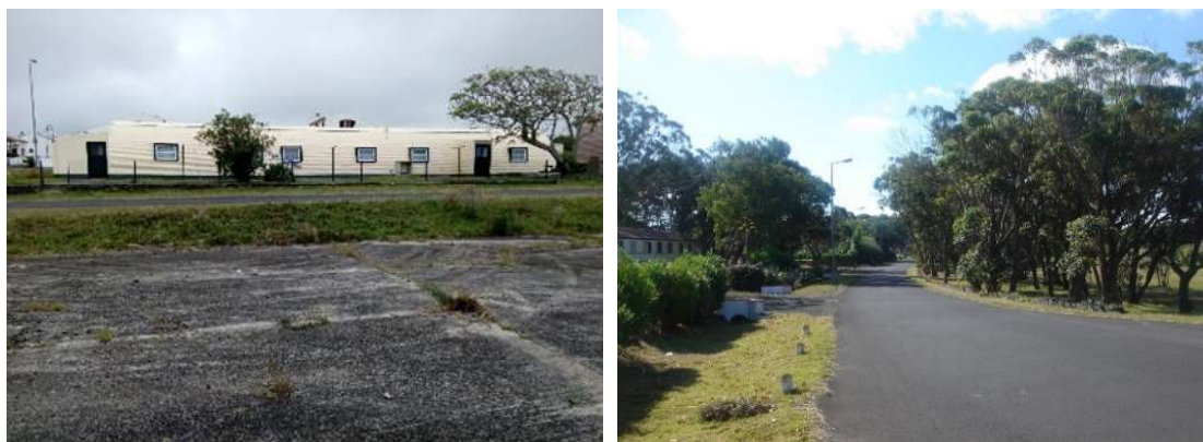
Figura 4.87 – Aspetos da Degradação das Vias de Circulação Automóvel (Fotos da Autora)
