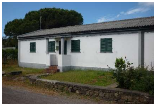
Figura 4.23 – Bairro Sta. Bárbara – Construção em alvenaria (Foto da autora)
