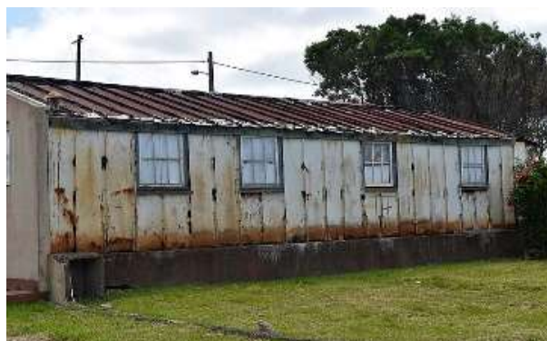
Figura 4.34 – Bairro da Almagreira – Construção Metálica (Ilhas de Valor)
