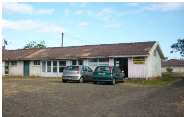
Figura 4.70 – Edifício da Antiga Cantina (Foto da Autora)
