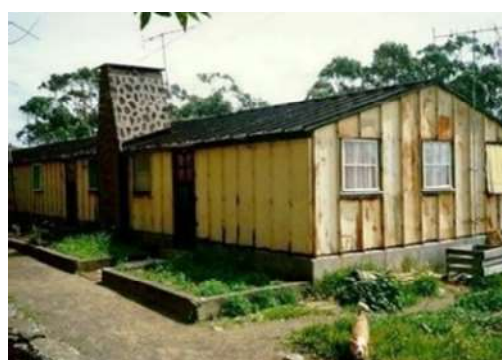
Figura 4.25 – Bairro Sta. Bárbara – Construção metálica (Ilhas de Valor)
