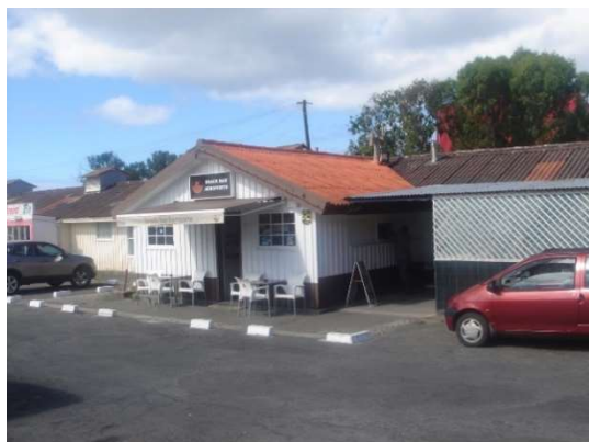
Figura 4.69 – Edifício da Antiga Cantina (Foto da Autora)
