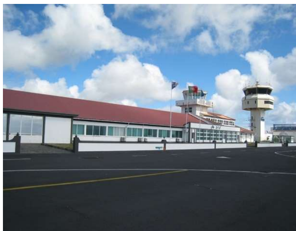
Figura 3.15 – Gare/Antiga Torre de Controlo e a Nova Torre de Controlo (Google.com)
