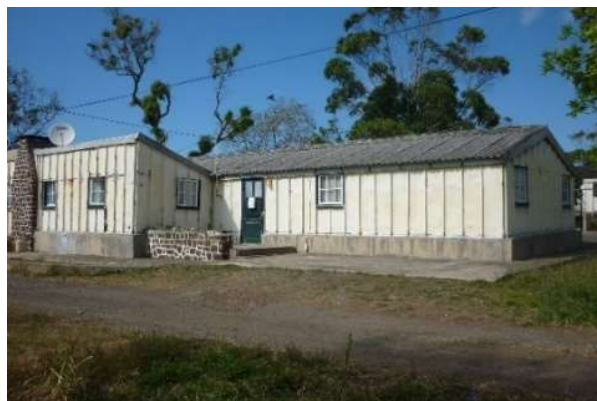
Figura 4.19 – Vista do Bairro de São Lourenço, Construção Metálica
