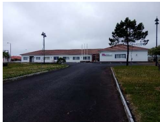
Figura 4.79 – Edifício Clube ANA (Foto da Autora)
