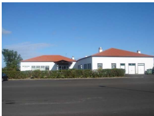
Figura 4.63 – Vista Atual do Hotel de Santa Maria (Foto da Autora)
