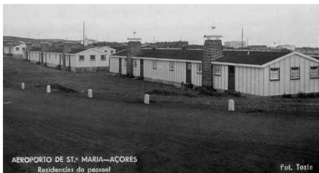
Figura 4.22 – Bairro Sta. Bárbara – Construções em Banda (Arquivo Foto Pepe)
