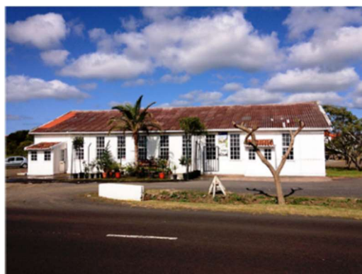
Figura 4.74 – Edifício da Padaria (Ilhas de Valor)
