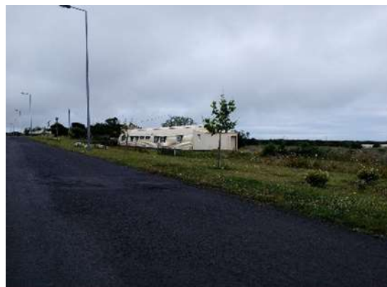
Figura 4.90 – Aspetos da Degradação das Vias de Circulação Automóvel (Fotos da Autora)
