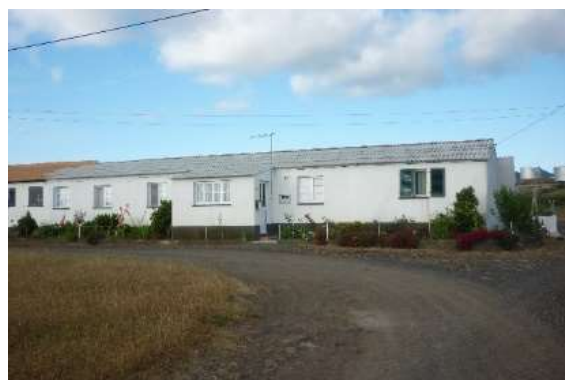
Figura 4.35 – Bairro da Almagreira – Construção em Alvenaria em 1947 (Ilhas de Valor)
