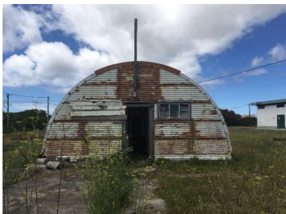
Figura 6.5 – Quonset Hut – Fachada (Foto da Autora)
