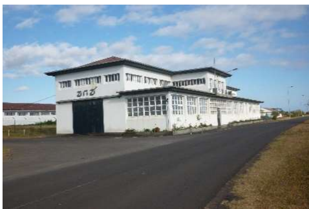
Figura 4.80 – Edifício das Antigas Oficinas (Foto da Autora)
