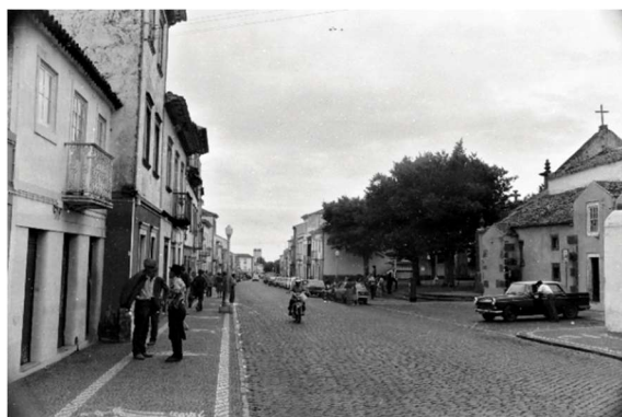
Figura 3.4 – Vista da Rua Principal de Vila do Porto (Arquivo Foto Pepe)
