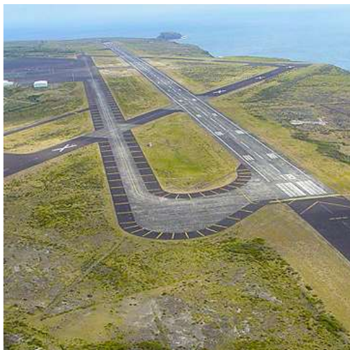
Figura 3.14 – Vista Aérea da Atual Pista do Aeroporto
