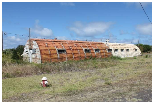
Figura 6.6 – Quonset Hut – Fachada (Foto da Autora)
