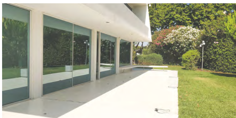
211, 212 | Vista da zona de acesso à habitação Janelas pertencentes ao atelier e pilar 213 | Banco que sobressai da fachada e faz a transição entre o lado nascente e sul 214 | Vista do espaço-entre proporcionado pelo balanço da varanda superior. Lado sul Casa Ruy Athouguia
