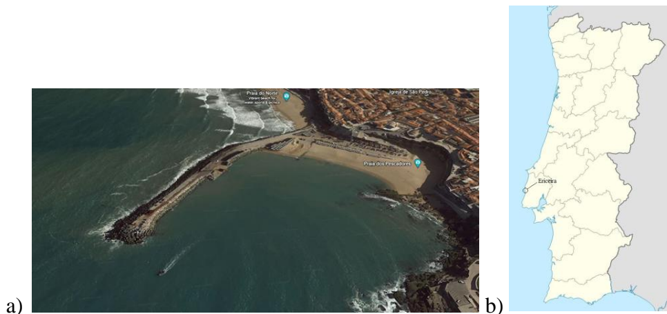
Figura 4.1 – a) Vista satélite do porto da Ericeira (Fonte: Google Earth, 8 de agosto de 2020); b) Localização do porto da Ericeira no mapa de Portugal continental.
