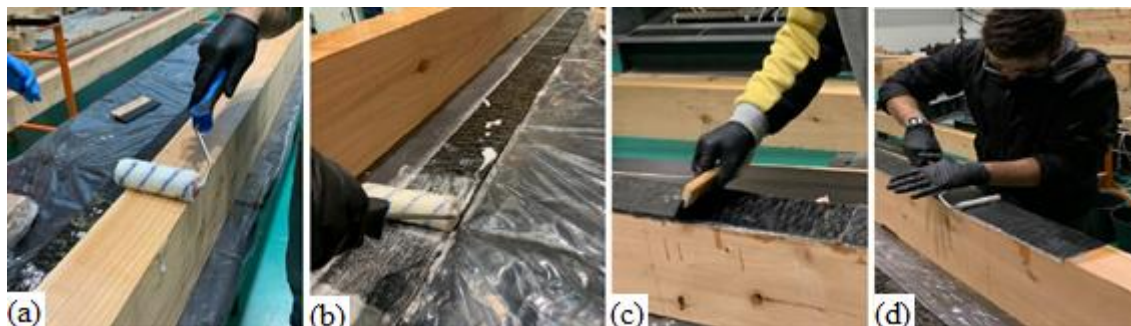
Figura 14 – Procedimentos de aplicação do sistema de mantas de FRP.
