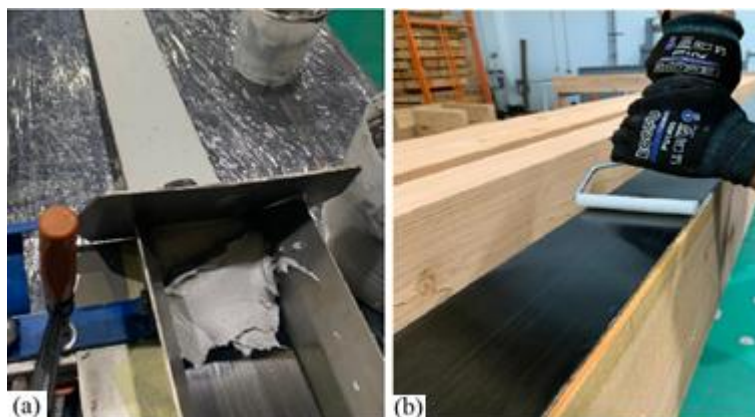
Figura 13 - Procedimentos de aplicação do sistema de laminados de FRP.
