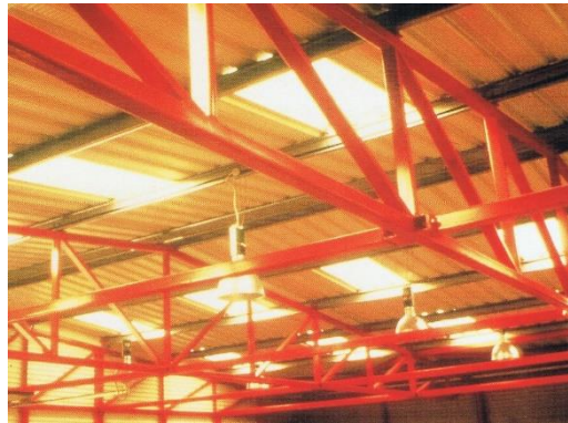
Figura 2.3 - Estrutura metálica protegida com tinta intumescente [8]
