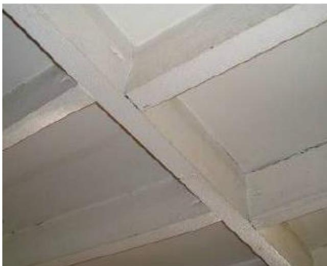
Figura 2.5 - Tarugamento em vigamento de secção retangular (Ilharco, 2006).
