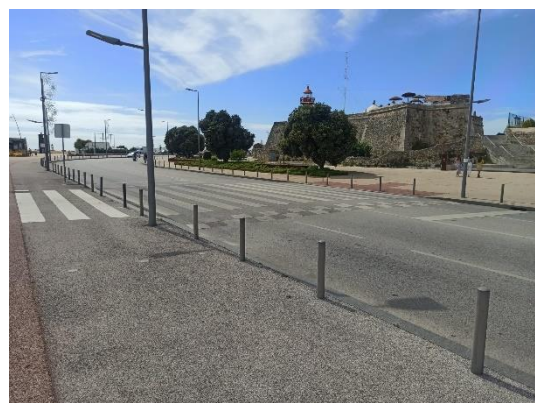
Figura 4.35 – Av. Espanha (situação atual)
