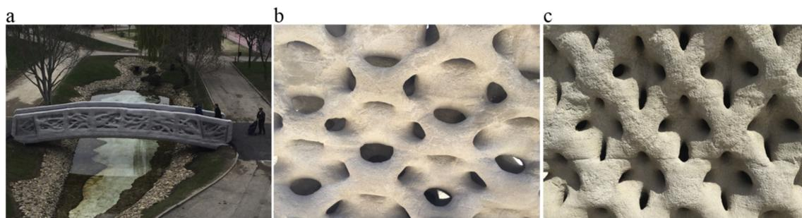
Figura 5.3 - Ponte pedonal em Madrid (a) e seus padrões (b-c), realizada pelo método D-Shape (Foto: Lowke, D. et al., 2018).
