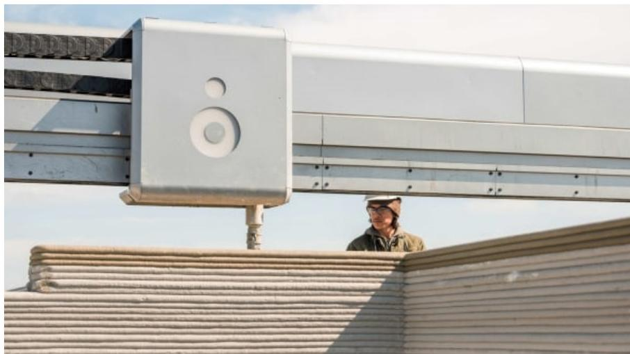
Figura 5.12 - Processo de construção com a impressora 3D em Austin (Foto: ICON, 2018).
