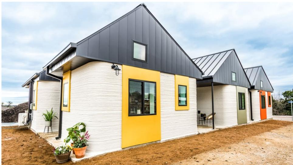
*Figura 5.10 - Casas impressas em 3D utilizando a tecnologia do Contour Crafting em Austin nos EUA (Foto: ICON, 2018).*
