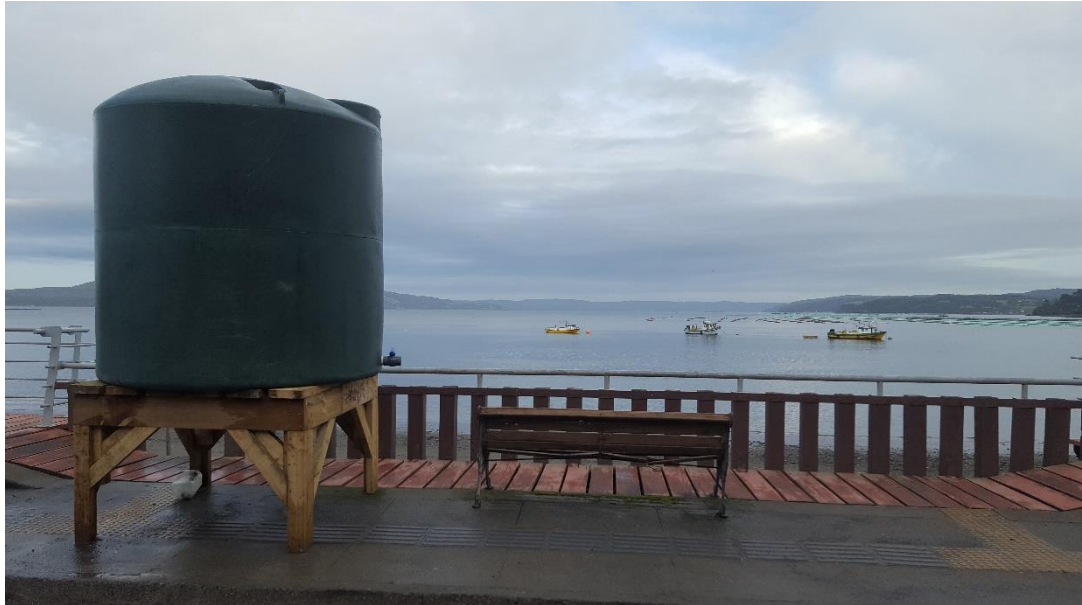
Figura 13: Estanque para reparto municipal de agua potable. Fuente: trabajo de campo (Queilen, julio 2018)
