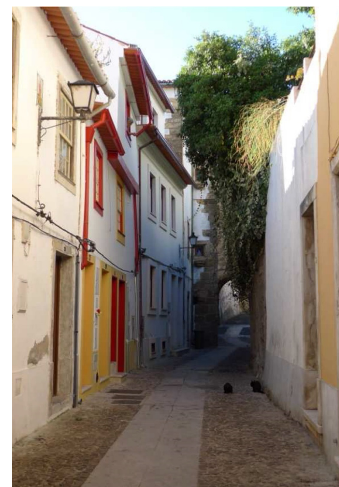
Figura 12 - Alta, rua reabilitada.
