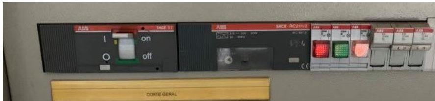
Figura AP. 2 Interruptor do corte geral.
