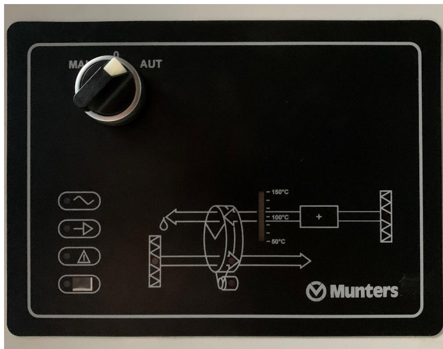
Figura AP. 16 Painel de ativação do desumidificador.
