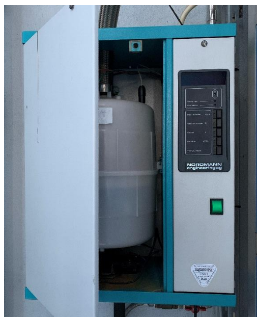
Figura 3.10 Humidificador Nordmann AT4.
