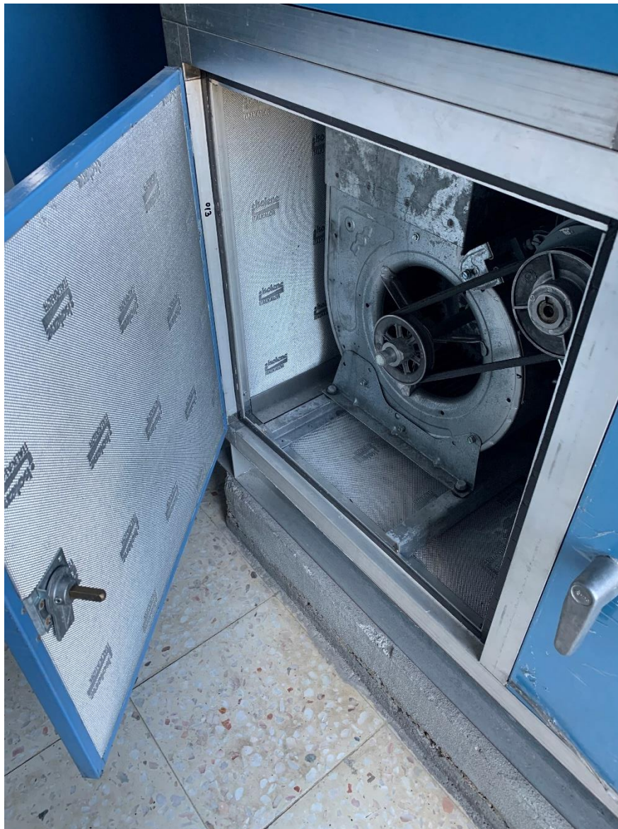
Figura 2.3 Ventilador centrífugo com motor elétrico acoplado
