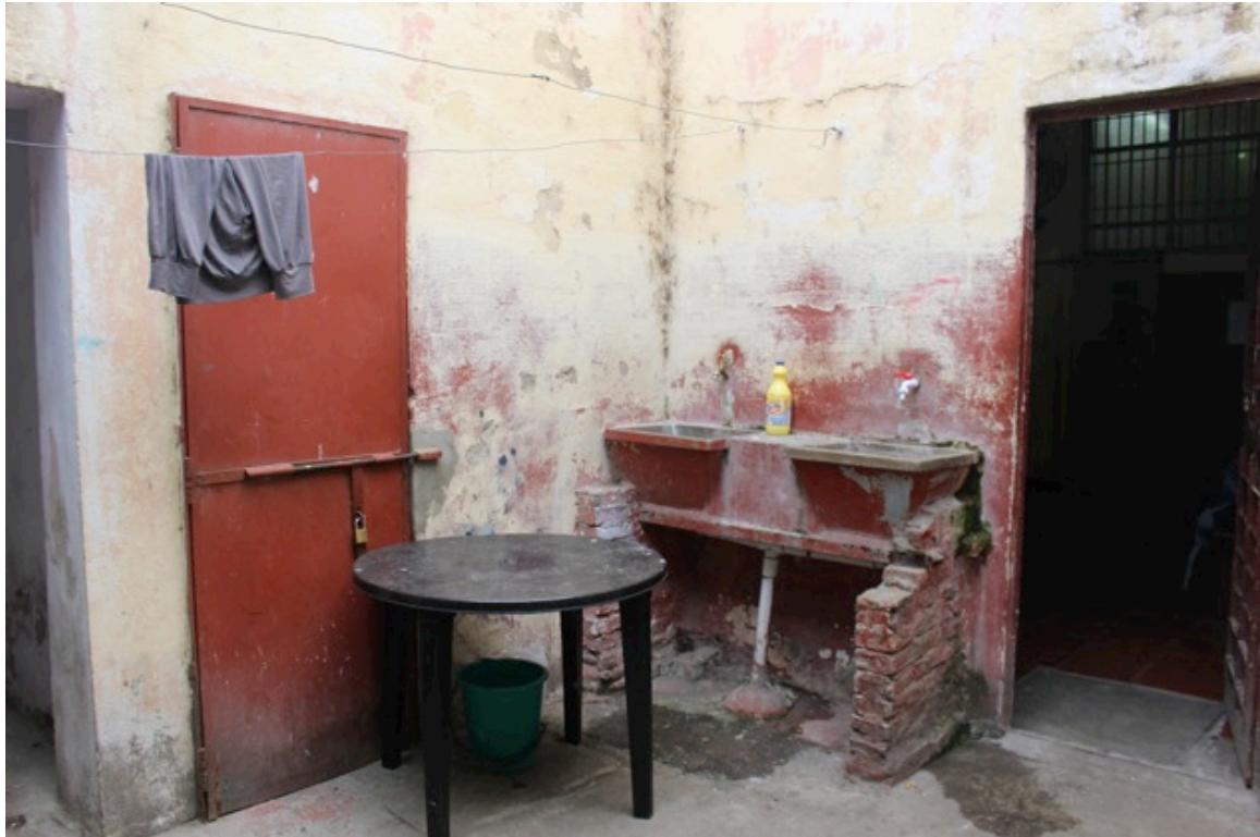
Foto 8. Patio del Pabellón “Planta Baja”, cárcel de Rosario.
