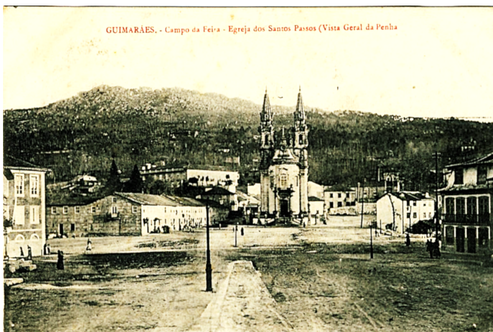
Figura 23– A «Fábrica da Eletricidade», Campo da Feira (1908). Fonte: Postal ilustrado de 1904, Coleção particular (Paula R. Nogueira). (A central está no plano à direita, destacando-se a chaminé e o fumo).
