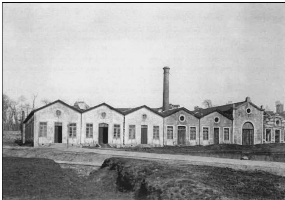
Figura 6 - Instalações e oficinas da Escola Industrial Francisco de Holanda (1894-1904). Fotografia cedida pela Muralha – Associação de Guimarães para a Defesa do Património (1880).
