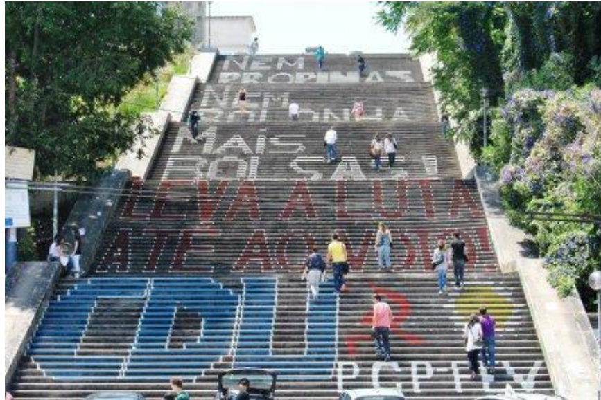
Figura 13: Vandalismo nas Escadas Monumentais de Coimbra
