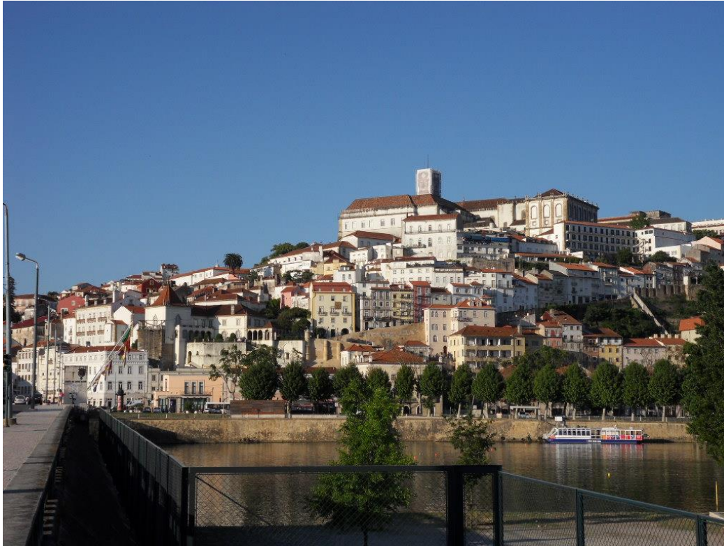
Figura 4. 1: Vista panorâmica da zona sudoeste do Centro Histórico de Coimbra, a partir do rio Mondego.
