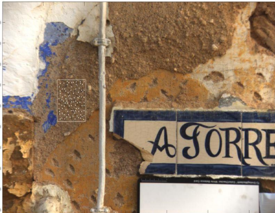
Figura 4. 88: Imagem original e o retângulo que representa a zona escolhida pelo utilizador que será a fonte da informação de textura bem como os pontos de amostragem espectral.
