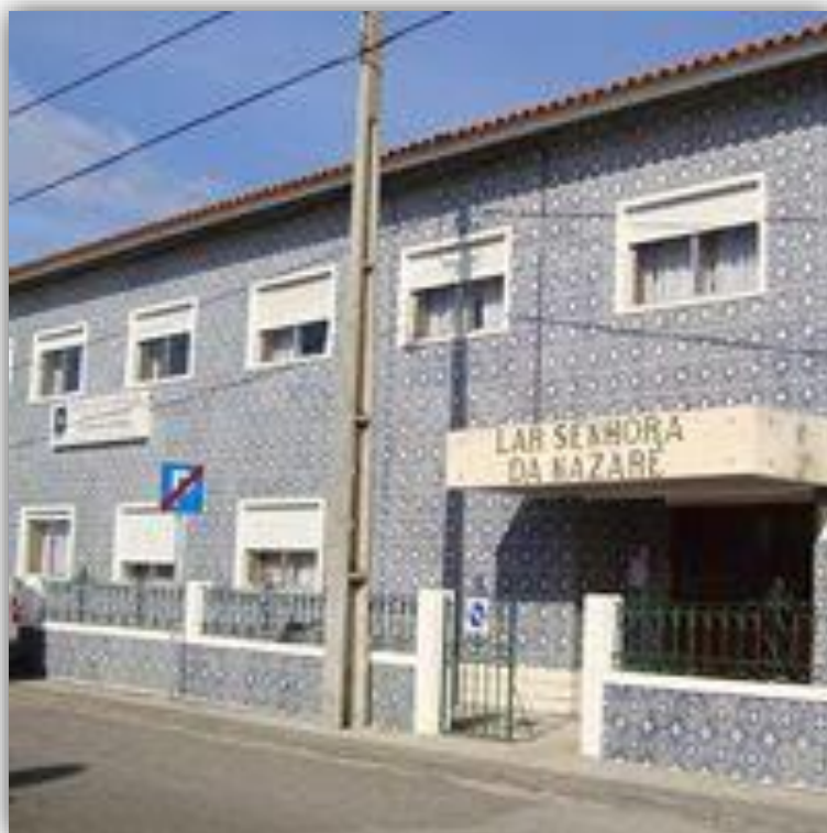
Figura 1: Centro Social e Paroquial de Nossa Senhora da Nazaré/ Edifício Sede
