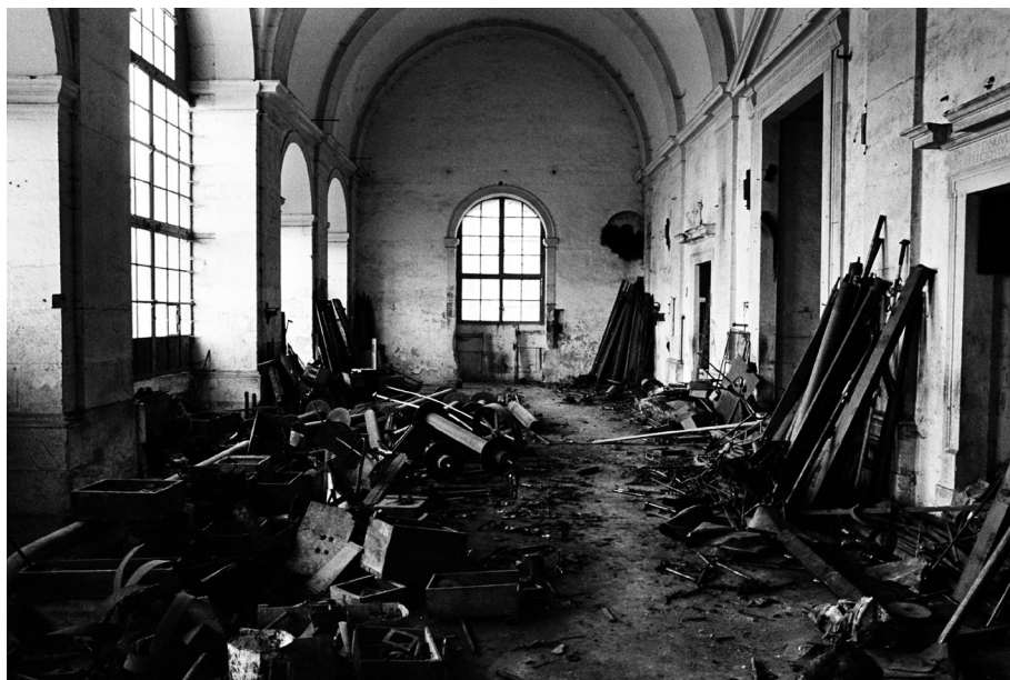
Espaços dismantelados da Fábrica de Lanifícios de Santa Clara, s/d. (APPM).
