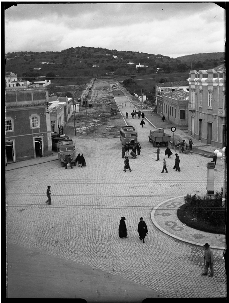
Figura 3 – Obras na Av. 25 de Abril (antiga Av. General Carmona) (propriedade AFCME, cota DFT7156)
