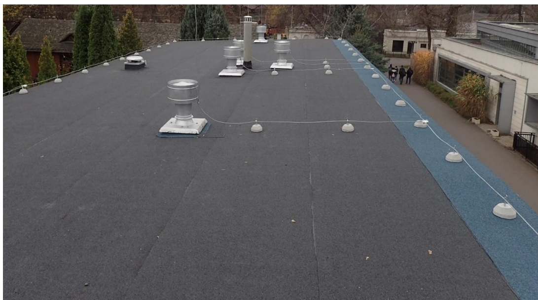
Figura 2.9 – Fotografia final da cobertura reabilitada no edifício localizado em Varsóvia.
