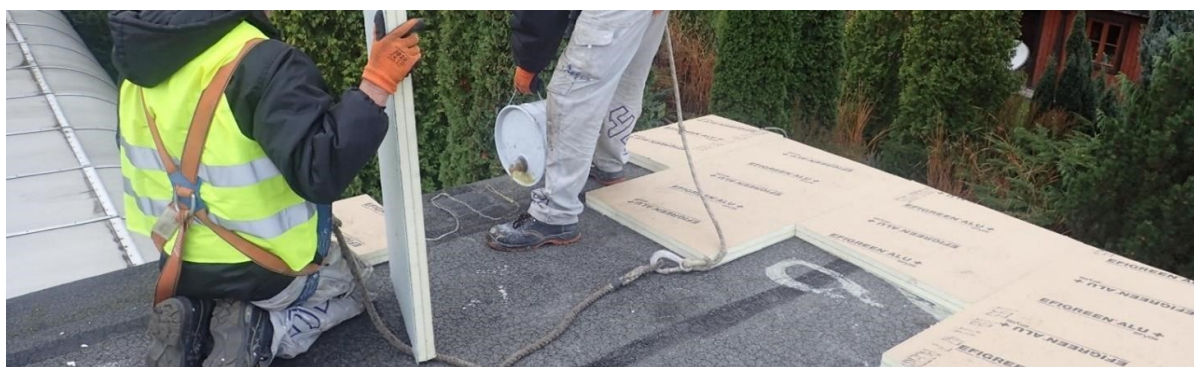
Figura 2.7 – Fotografia dos trabalhos de colocação da espuma poliuretano antes da aplicação dos painéis VIP.
