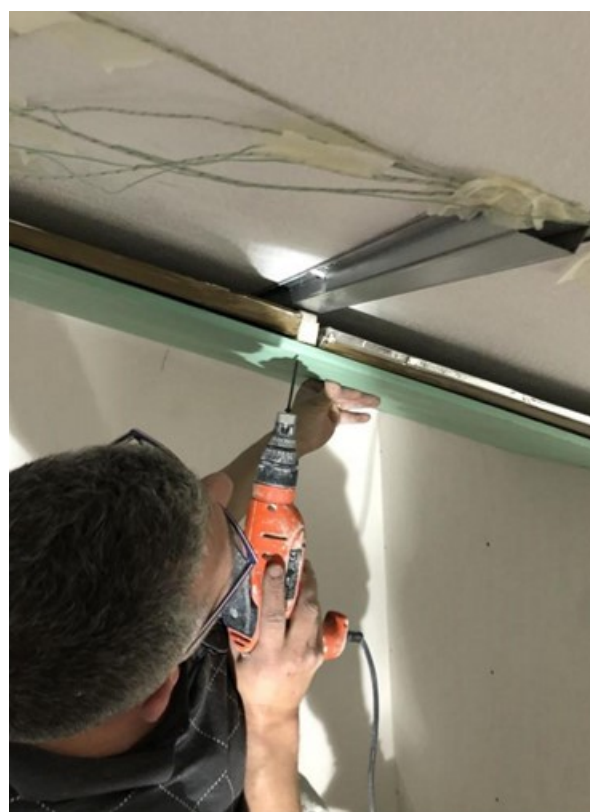
Figura 2.14 – Fotografia da colocação das placas contendo os painéis ao perfil.
