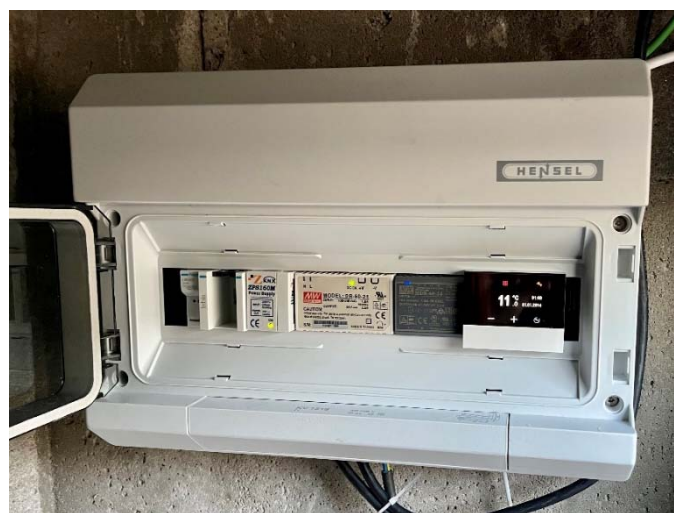
Figura A.8 – Montagem final dos dispositivos
