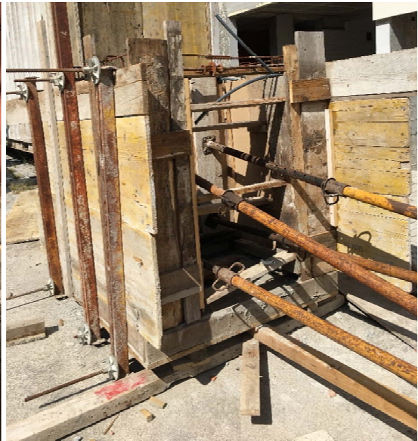
Figura A.2 – Execução de cofragens e betonagem
