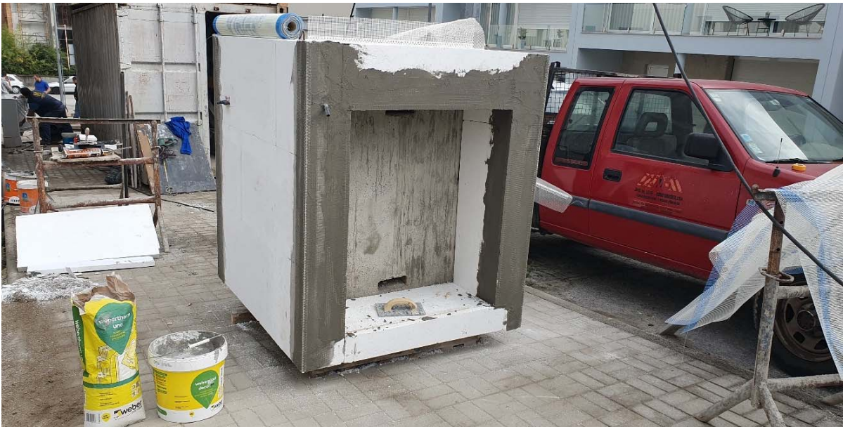
Figura A.3 – Colocação de sistema ETICS
