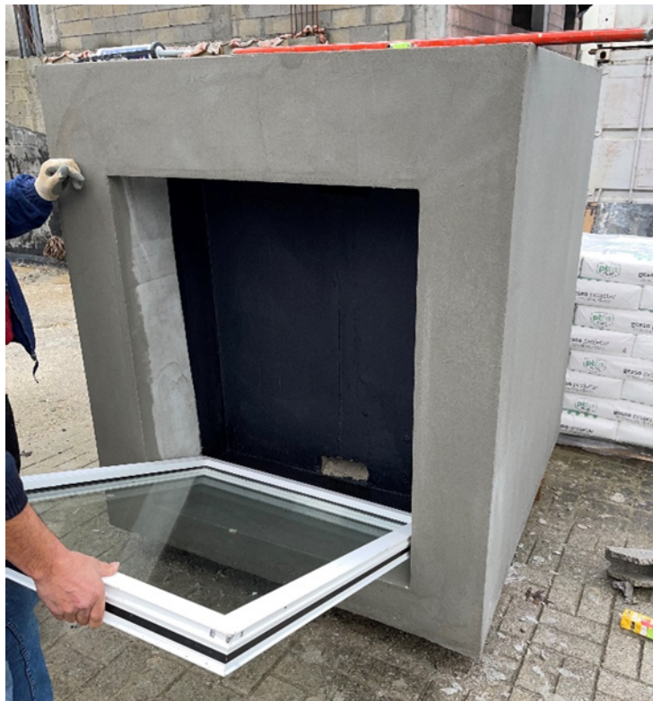
Figura A.4 – Colocação de vitral na parede de Trombe
