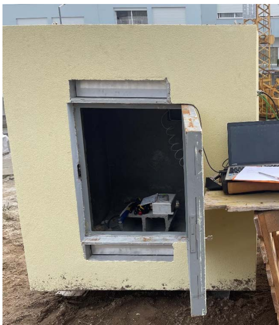
Figura 6.4 - Fotografia das grelhas de ventilação
