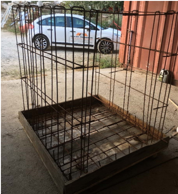
Figura A.1 – Execução de armaduras
