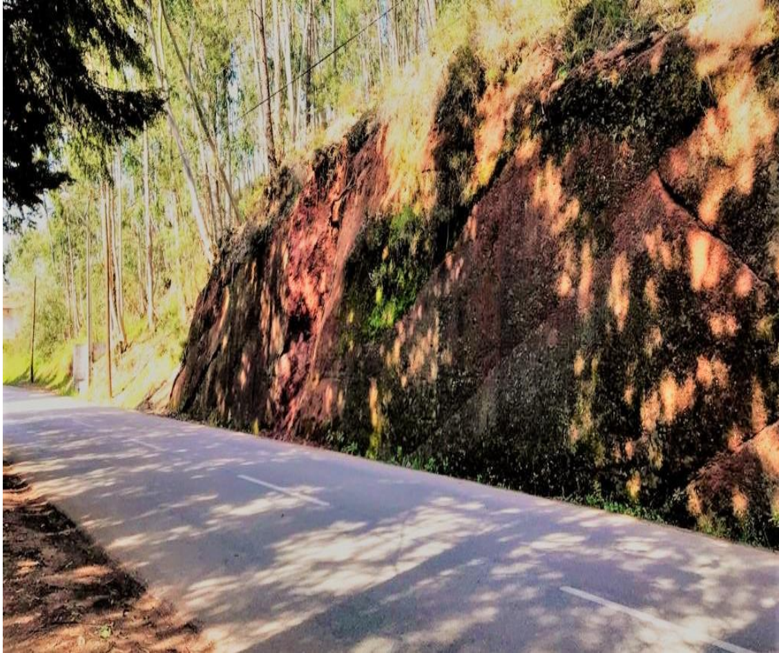
Figura 20- Talude Estrada Principal do Jardim.
