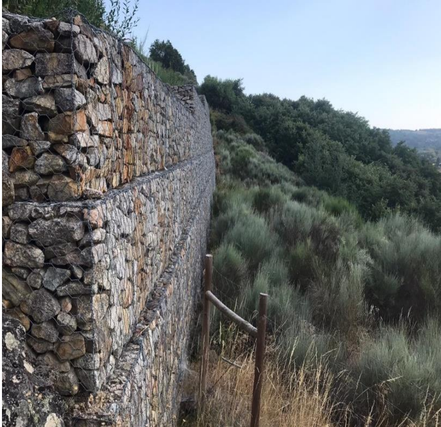
Figura 33- Muro de Gabiões de Aterro, localizado no IP2 (Trancoso - São Pedro).
