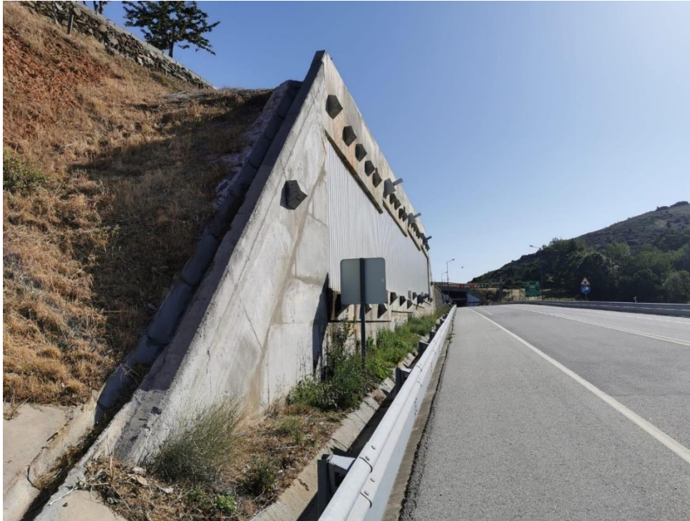
Figura 37- Muro de Betão, localizado no IP2 (Macedo de Cavaleiros- Bornes).
