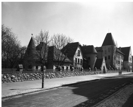
Figura 88. Escola e Creche de Károly Kós, 1910
