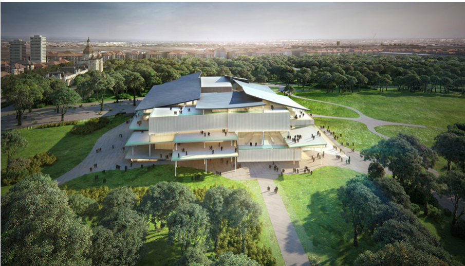
Figura 88. Nova Galeria Nacional do atelier SANAA, Render do projeto em construção
