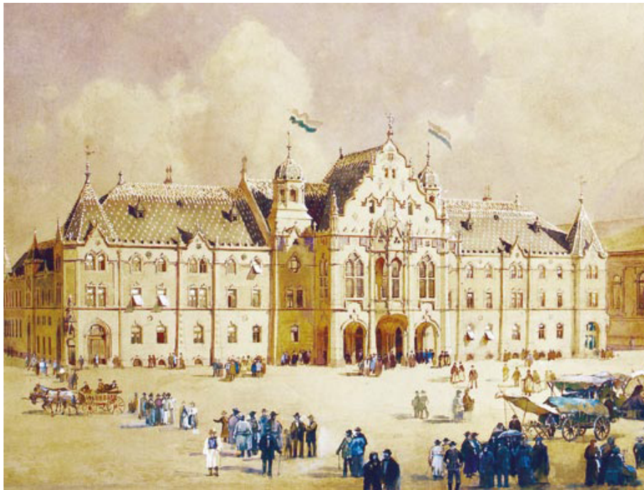
Figura 47. Cămara Municipal de Kecskemét de Ödön Lechner (1893-97)
