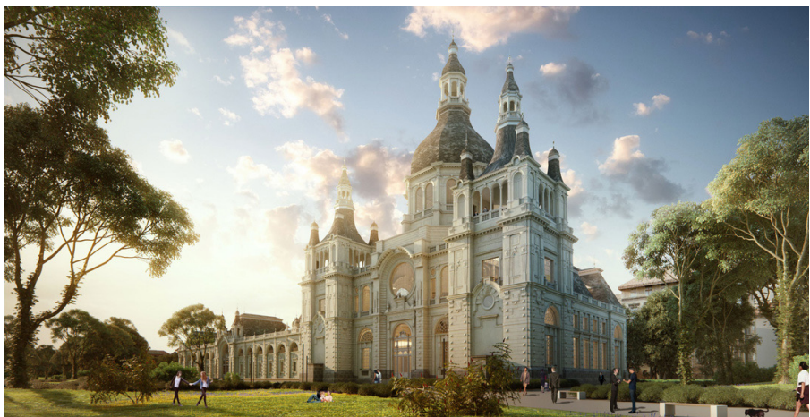
Figura 86. Museu da Inovação, Render do projeto em construção
