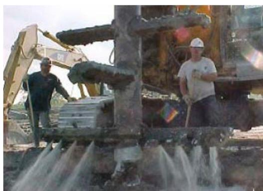
Figura 4.13 Aplicação da técnica de Deep Soil Mixing por via úmida (Topolnicki, 2003)
