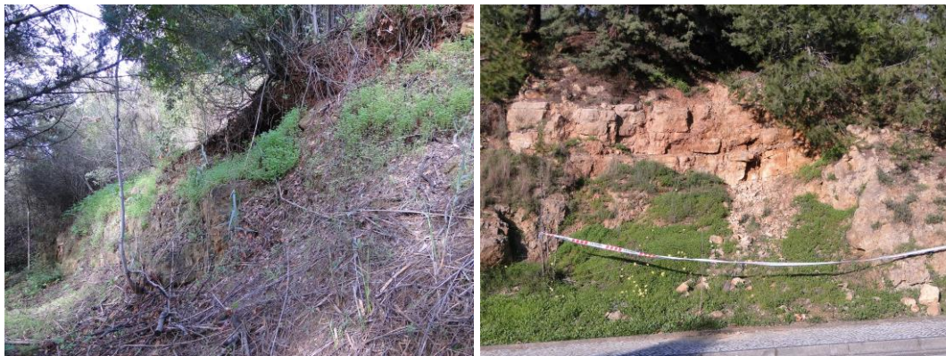
Fig. 2.5 – Registo fotográfico de deslizamentos (esq.) e queda de blocos (dir.)
