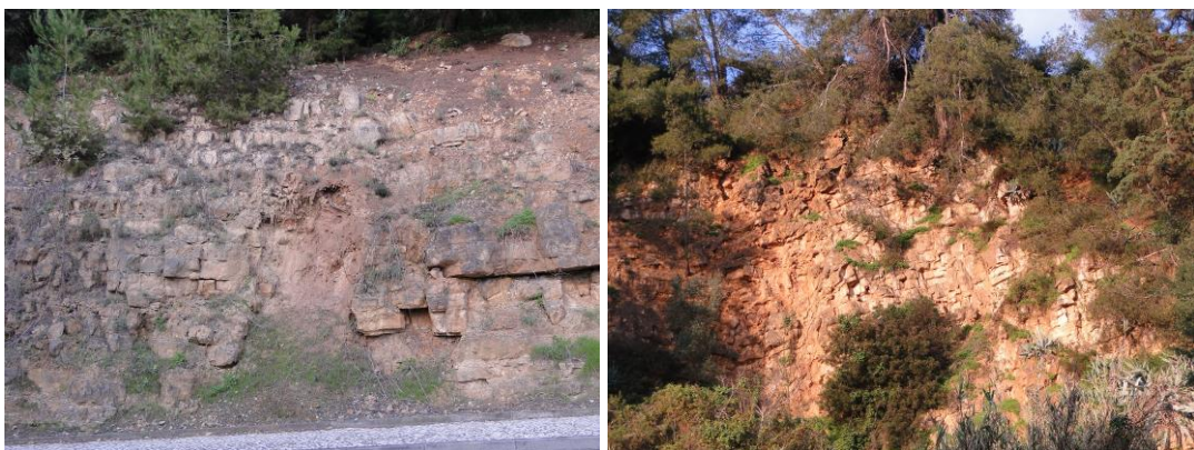
Fig. 2.6 – Registo fotográfico de cones de acumulação e solo de alteração
