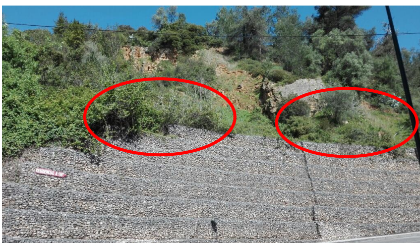
Fig. 5.2 – Registo fotográfico do muro de gabiões localizado na Zona M
