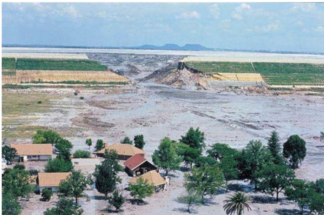
Figura 20 - Liquefação estática causadora do rompimento da barragem de rejeitos de ouro (Merriespruit, África do Sul, 1994)
