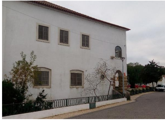
Figura 136 - Fachada norte do moinho de Cortes
