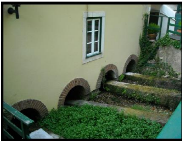
Figura 112 – Cubos ainda visíveis
