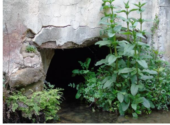
Figura 152 - Cabouco com estrutura de pedra e madeira.
