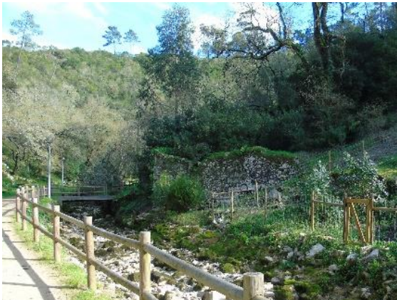
Figura 183 - Implantação do moinho junto à nascente
