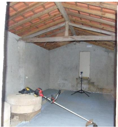
Figura 154 - Interior do moinho ainda em fase de reabilitação
