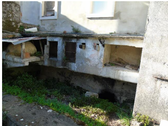
Figura 102 - Fachada traseira do moinho
