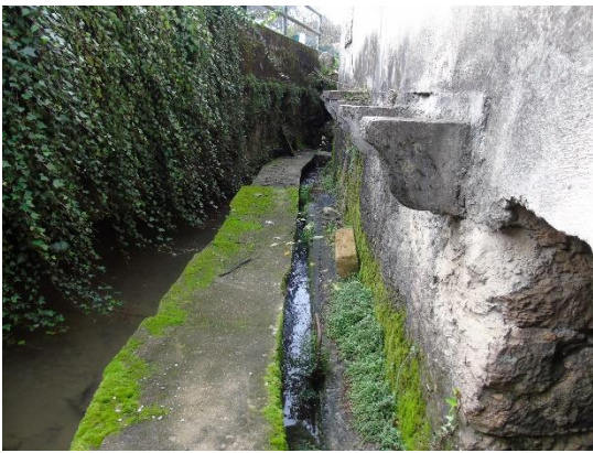
Figura 169 - Acesso ao piso inferior do moinho
