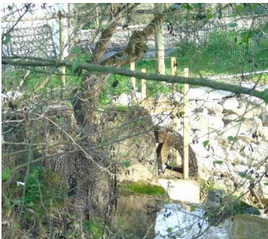
Figura 155 - Azenha inserida recentemente
