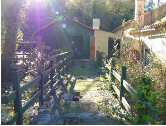
Figura 123 - Volumes anexos a sul do conjunto edificado
