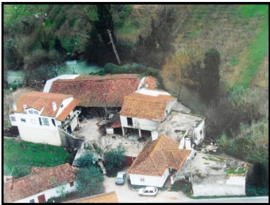
Figura 205 - Foto aérea do moinho do Pombal antes do início da reabilitação
