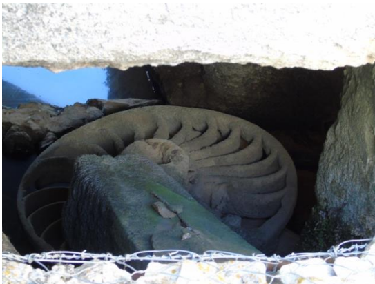
Figura 81 - Roda horizontal presente no cabouco
