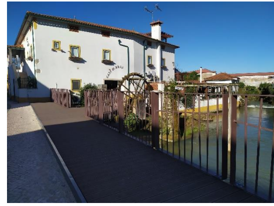
Figura 65 - Restauro do gradeamento da ponte de Cortes
