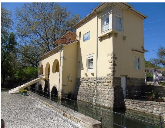
Figura 92 - Casa solar da Quinta
