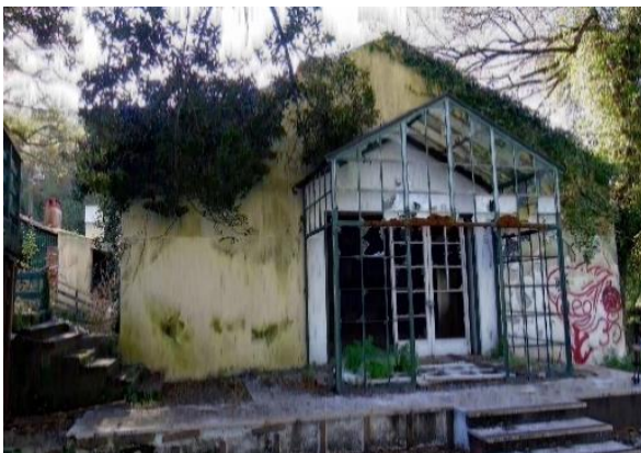
Figura 115 - Fachada nascente do moinho
