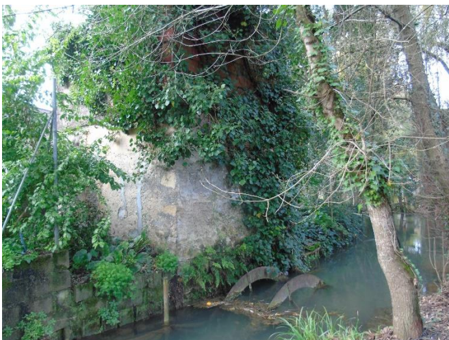
Figura 223 - Terceiro moinho da Ponte do Cavaleiro (moinho da Minheca)
