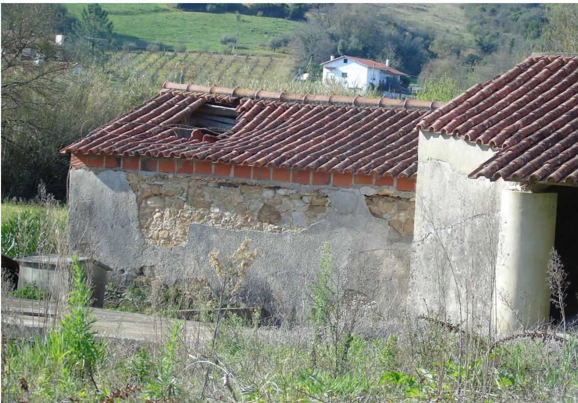
Figura 82 - Telhado degradado
