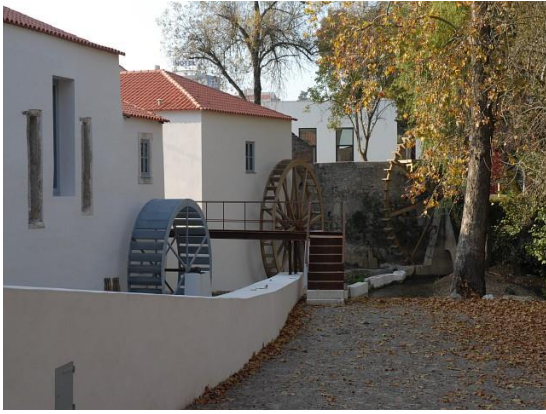
Figura 23 – Moinho do Papel, sistema de azenha na sala de moagem a poente do edificado
