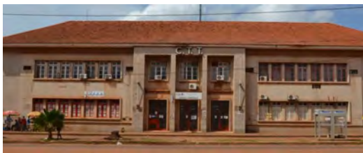
Figura 48 - Edifício dos CTT em Bissau
