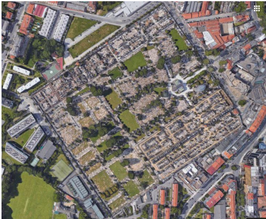
Figura 18. Vista aérea do cemitério de Agramonte, no Porto.
