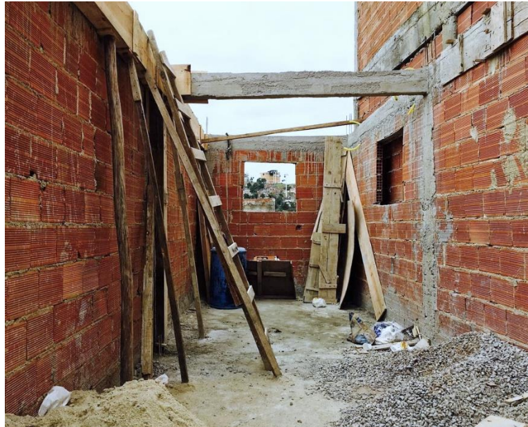
Imagem 31. Casa em construção no Complexo do Alemão no Rio de Janeiro. (Fotografia de Josiane Santana. Projeto Favelagrafia.)
