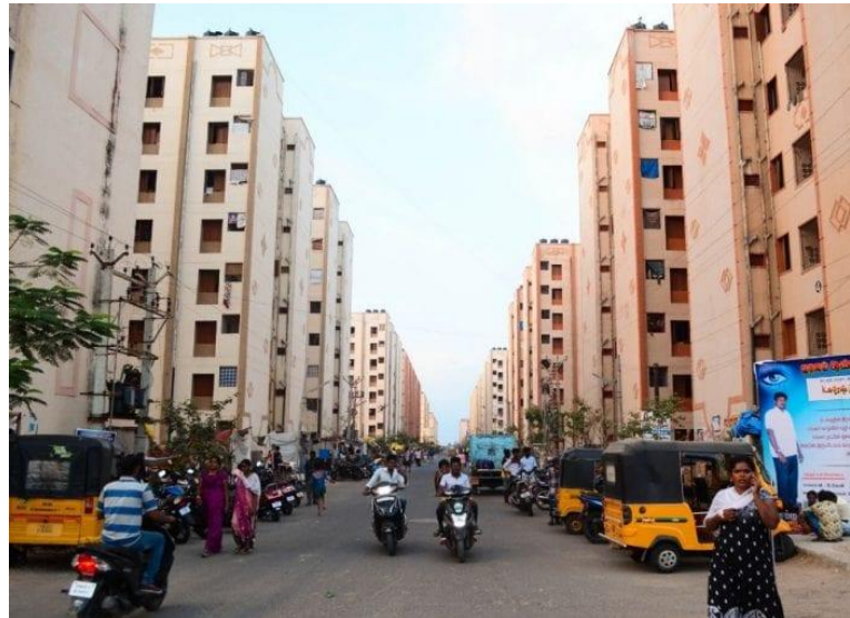
Imagem 64. Edifícios em altura localizados nas periferias urbanas em Chennai na Índia para reassentamento de moradores retirados por uma operação de slum clearance . (Fotografia de Vignesh KJ.)
