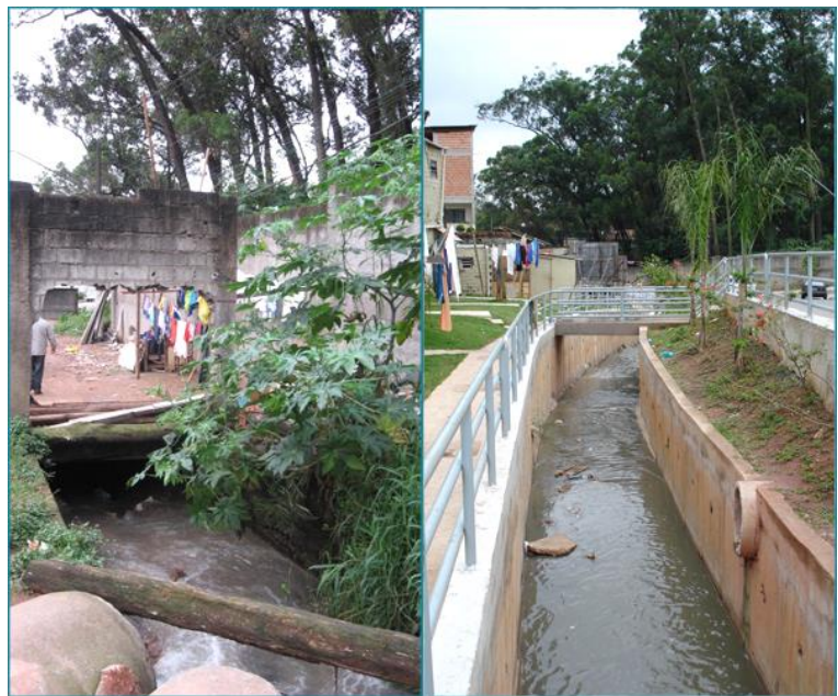
Imagem 124. Antes (esquerda) e depois (direita) da canalização do Córrego do Brejo em Paraisópolis.
