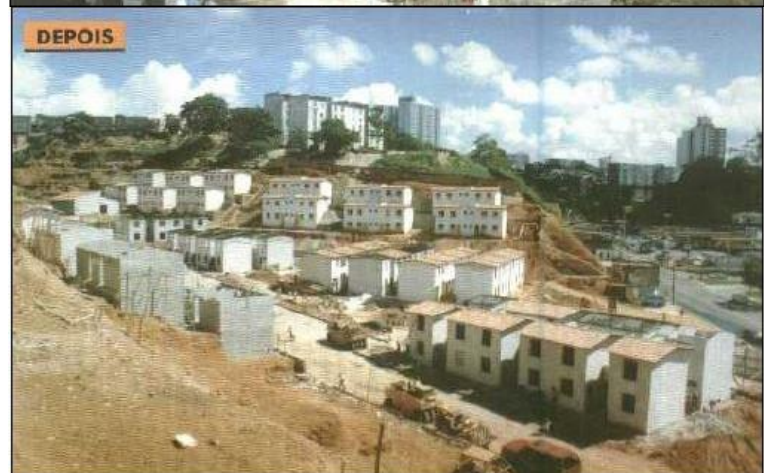
Imagem 65. Antes e depois da intervenção na comunidade Yolanda Pires, na Bahia no Brasil. Exemplo de ação de limpeza e reconstrução total do assentamento.
