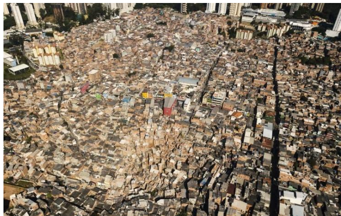
Imagem 99. Vista Aérea de Paraisópolis. Ao centro região com topografia mais acidentada de ocupação recente. À direita malha reticular do centro consolidado. (Fotografia de Eduardo Knapp. Arquivo Folhapress.)
