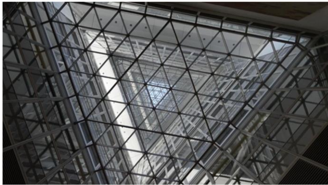
Figura 12 – Vista do átrio central com a estrutura metálica e vidro
