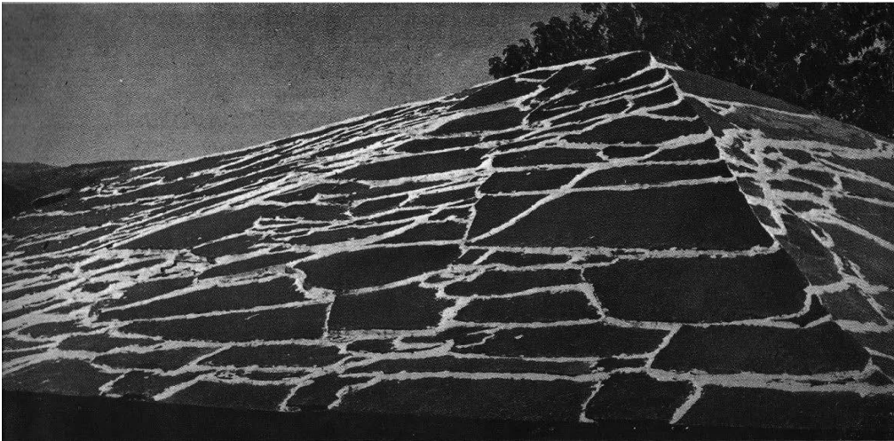
Figura 38 - Argamassa nas juntas da lousa, aldeia de Montes
