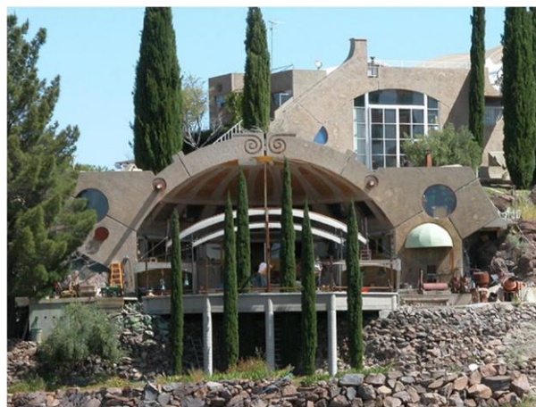
Figura 18 – Abside de Fundição
