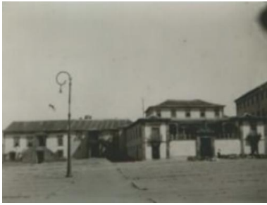
Figura 58 – Casas antigas que se devem conservar (Praça Conde Agrolongo).
