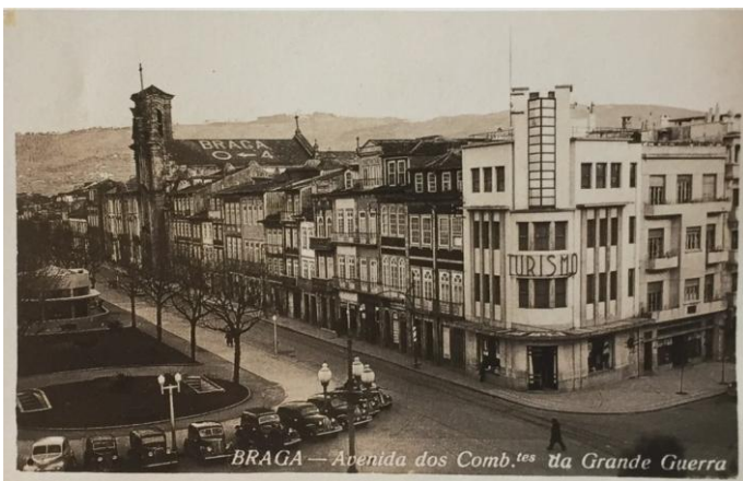
Figura 20 - Avenida dos Combatentes da Grande Guerra (atual Avenida Central) e início da Avenida Marechal Gomes da Costa - Edifício de Turismo (194?).
