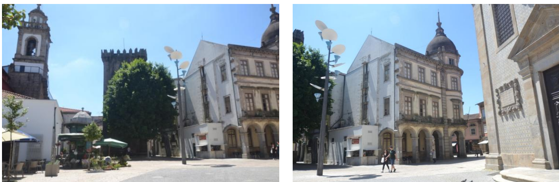
Figura 52 – Vista da Torre de Menagem pelo lado Norte, a altura excessiva da antiga Escola Industrial e arcadas.
