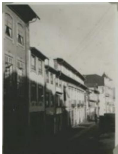
A 12 – Avenida Marechal Gomes da Costa – Casas destinadas a serem demolidas, das quais uma tem 29 metros de fachada.
