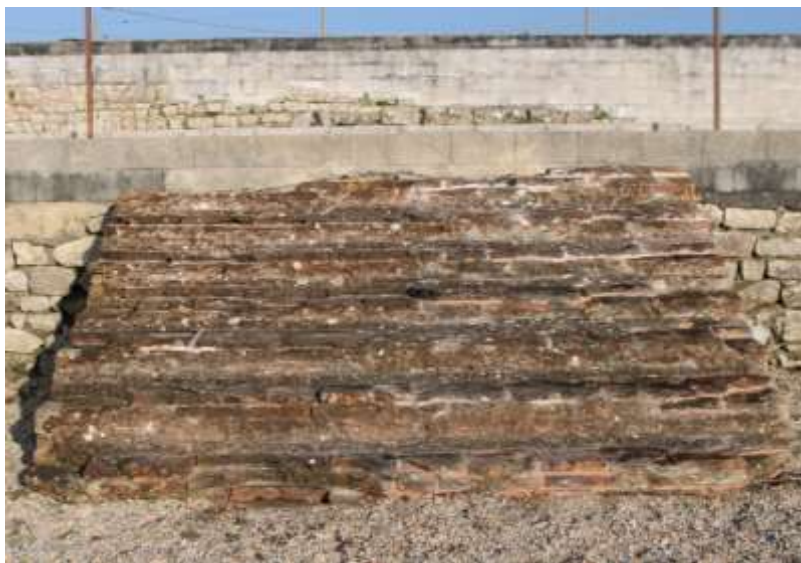
Figura 46: Aspecto da escadaria durante o processo de refecimento das juntas.
