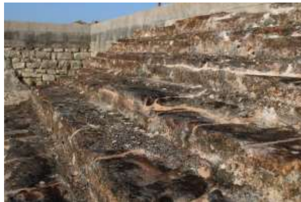
Figura 47: Pormenor do refecimento.
