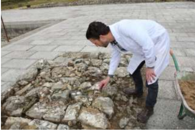
Figura 48: Limpeza e remoção da camada vegetativa.
