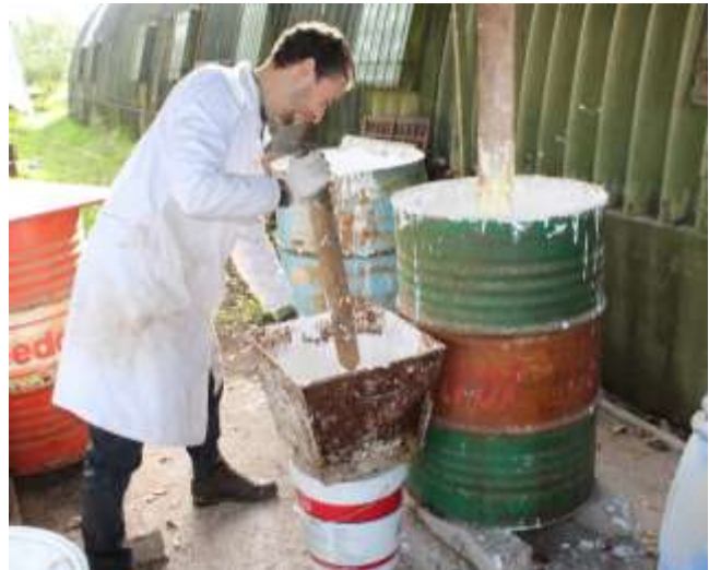
Figura 32: Crivagem da cal apagada.
