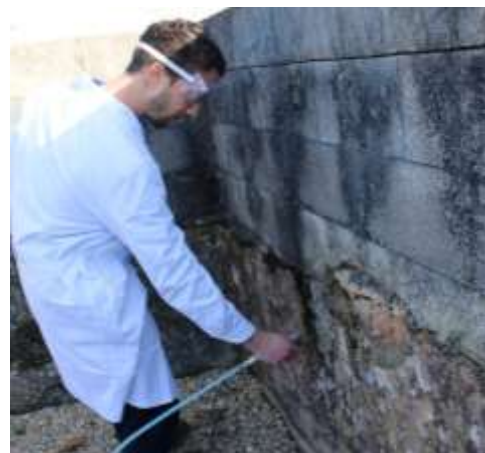
Figura 36: Limpeza com pistola.
