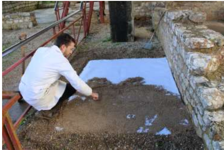
Figura 6: Aplicação do material inerte sobre a manta de geotêxtil.
