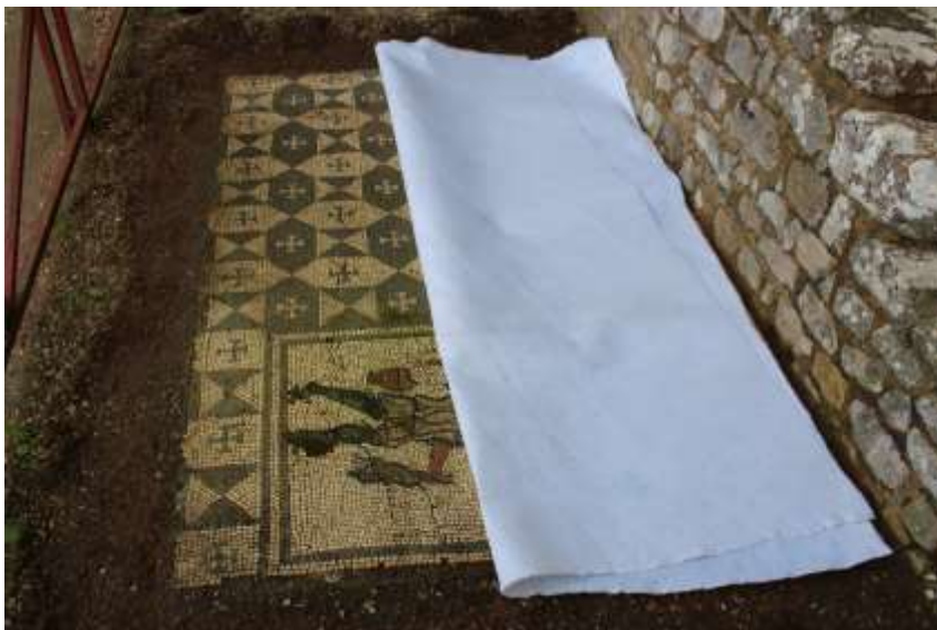
Figura 5: Colocação de manta geotêxtil sobre o mosaico.
