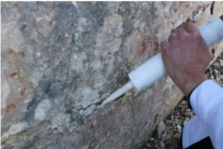
Figura 40: Injeção de argamassa de fixação.
