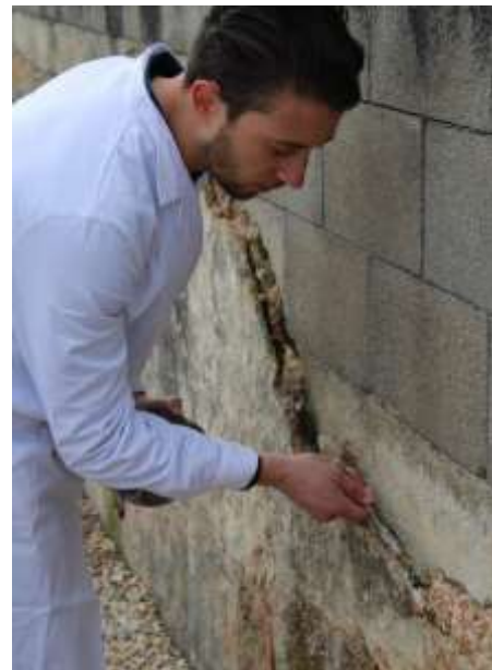
Figura 41: Aplicação de argamassa de capeamento.
