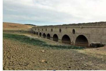
Ponte do rio Mourinho, Santa Susana (Setúbal)
