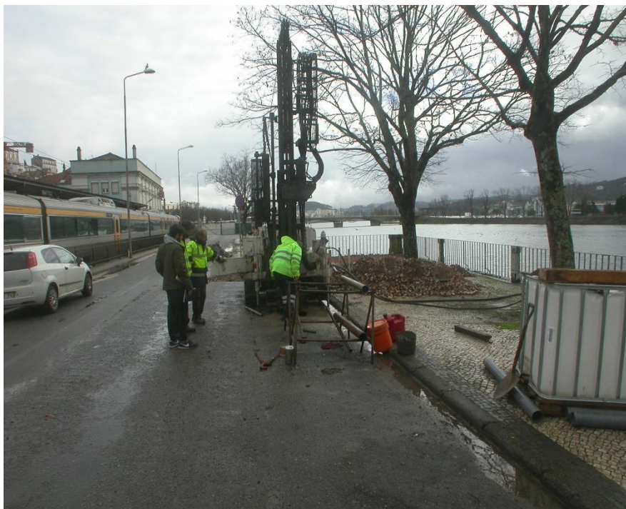
Figura 9 - Execução final da sondagem 2019S2, a 28 de janeiro de 2019 (Foto: Pedro P. Cunha)
