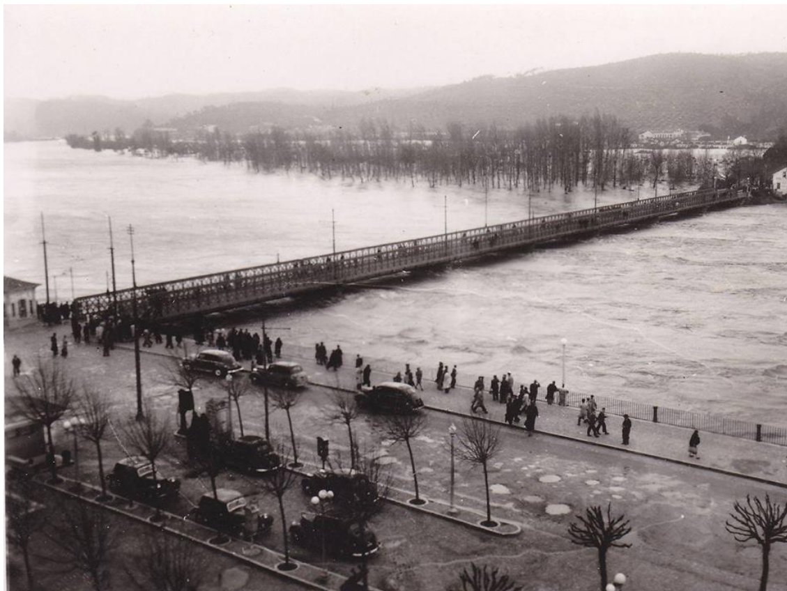
Figura 5 - Cheias de 1948. Podemos ver que o rio subiu até quase a altura do tabuleiro da ponte e a margem esquerda foi inundada.
