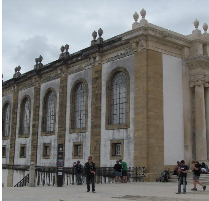
Figura 19. Biblioteca Joanina no Pátio das Escolas onde se observa a aplicação de dolomia em cunhais.
