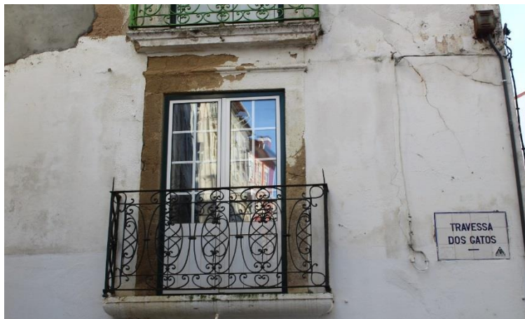
Figura 20. Aplicação da dolomia no lintel da janela.
