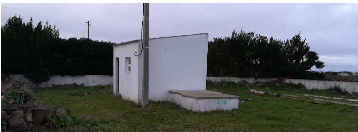
Figura 4.12: Casa da captação do furo F13, que se encontra em manutenção.
