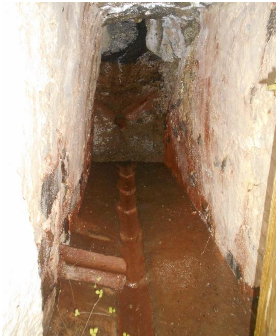
Figura 4.6: Captação por telhas da nascente N14.
