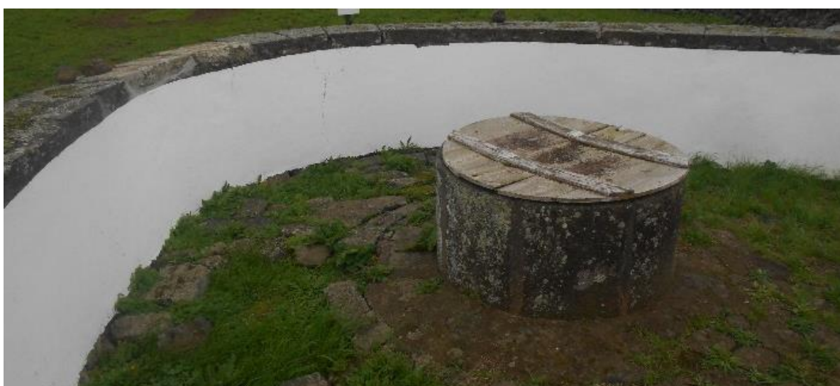
Figura 4.9: Poço P3, localizado na Plataforma NW da ilha Graciosa.
