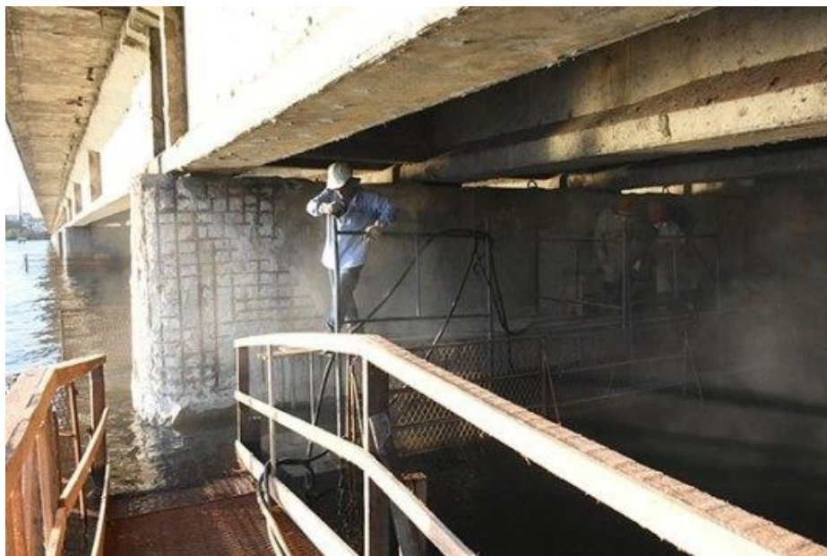
Figura 4.16 – Início da obra de reabilitação. (Marinho, 2019)
