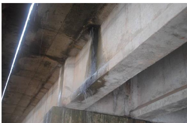
Figura 4.7 - (a) Dreno posicionado sobre o talão inferior da viga; (b) Junta longitudinal com problemas de vedação (Maia Melo Engenharia , 2012).
