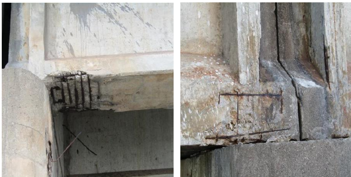
Figura 4.14 – Deterioração no lado direito da estrutura; (a) Estaca de betão armado desconfiada; (b), (c) e (d) Pilares de betão armado com corrosão avançada (DNIT, 2018).
