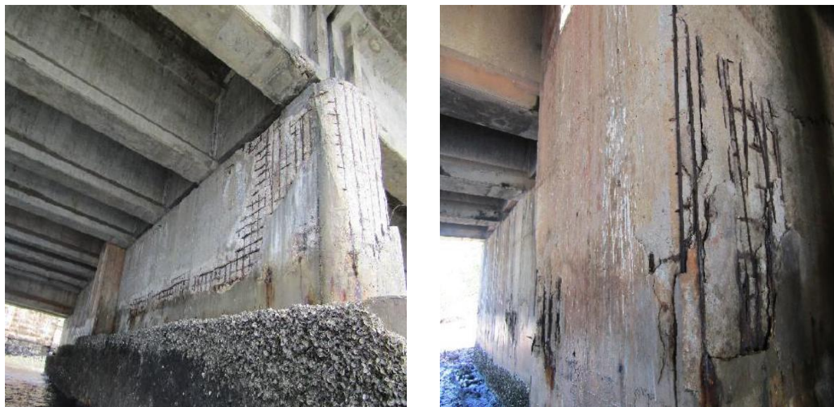
Figura 4.14 – Deterioração no lado direito da estrutura; (a) Estaca de betão armado desconfiada; (b), (c) e (d) Pilares de betão armado com corrosão avançada (DNIT, 2018).
