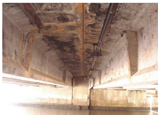
Figura 4.7 - (a) Dreno posicionado sobre o talão inferior da viga; (b) Junta longitudinal com problemas de vedação (Maia Melo Engenharia , 2012).
