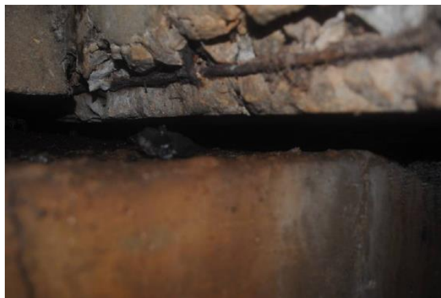
Figura 4.6 – Detalhe do aparelho de apoio da obra antiga (Maia Melo Engenharia , 2012).
